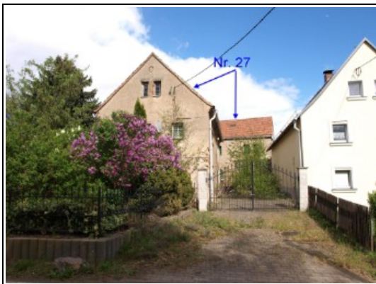
straßenseitige Ansicht aus Richtung Westen
