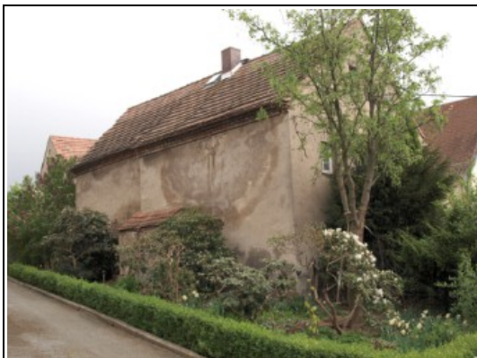
straßenseitige Ansicht der Grenzbebauung des Wohnstallhauses aus Richtung Nord-west
