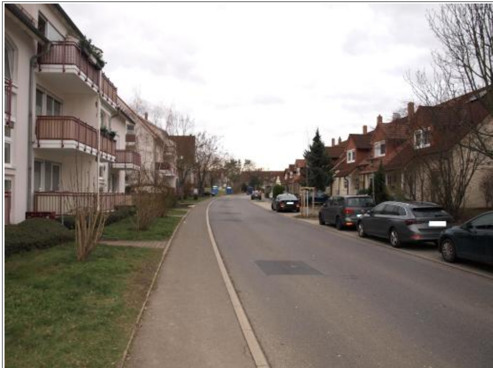
Abbildung 12: Teilansicht der Wohnanlage (links) in Höhe des Sondereigentums Nr. F 1.02 in Richtung Süden
