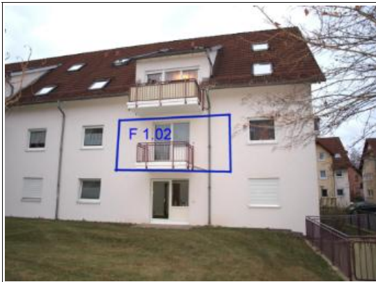
gartenseitige Ansicht SE-Nr. F 1.02 im 1. OG
