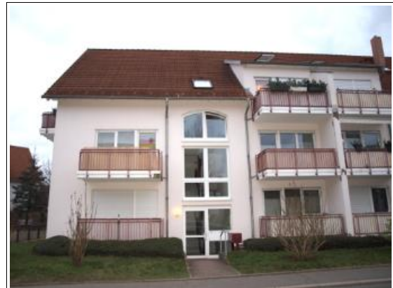
straßenseitige Ansicht Hauseingang
