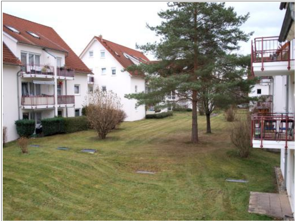
Abbildung 9: gartenseitige Ansicht der Eigentumswohnungsanlage
