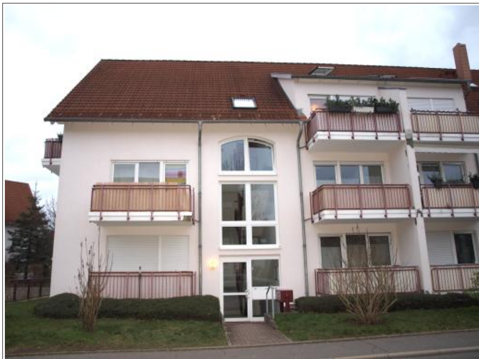
Abbildung 8: straßenseitige Ansicht Hauseingang Am Weißiger Bach 12a
