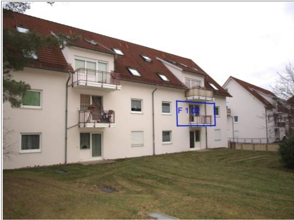
Abbildung 11: gartenseitige Ansicht mit SE-Nr. F 1.02 im 1. OG
