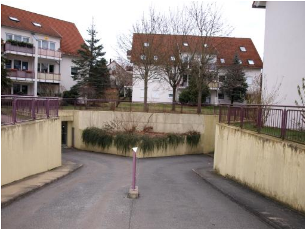
Abbildung 10: Zufahrt zur hauseigenen Tiefgarage
