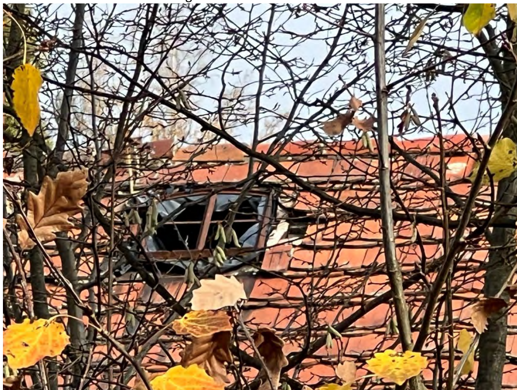
Beispiel für offene Stellen im Dach
