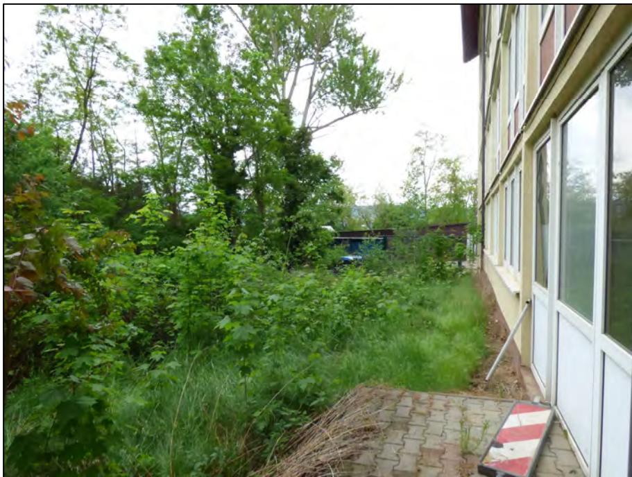
Blick auf Gebäuderückseite Haus 4 und nachbarliche Bebauung im Hintergrund
