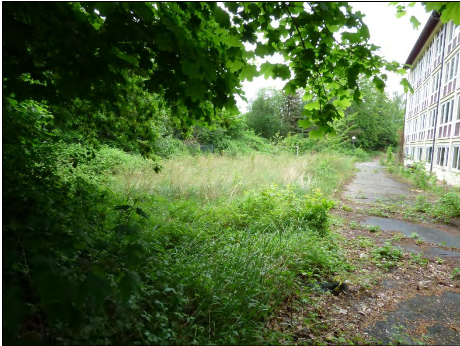
Rückansicht Haus 4 und Außenanlagen
