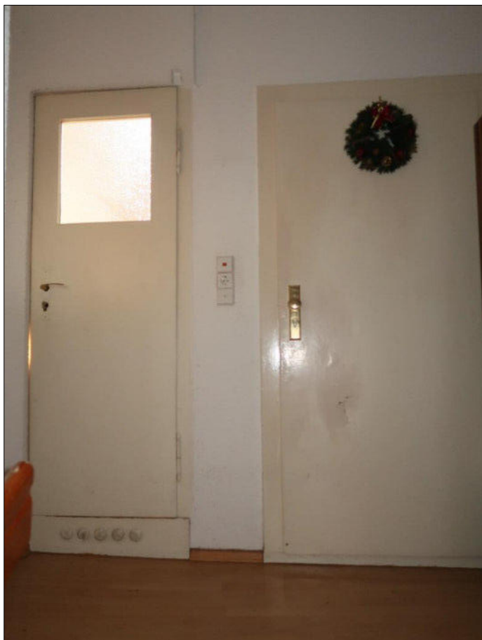
Bild 14: 2. OG, Zugang zur ETW Nr. 1 rechts, Zugang zum Spitzboden oder Nebengelass links
