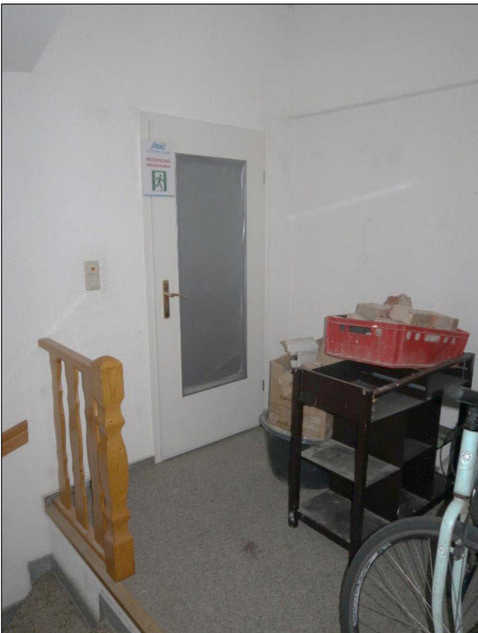
Bild 10: OG, Gemeinschaftseigentum Treppenhaus (Zugang zum Teileigentum Nr. 3)
