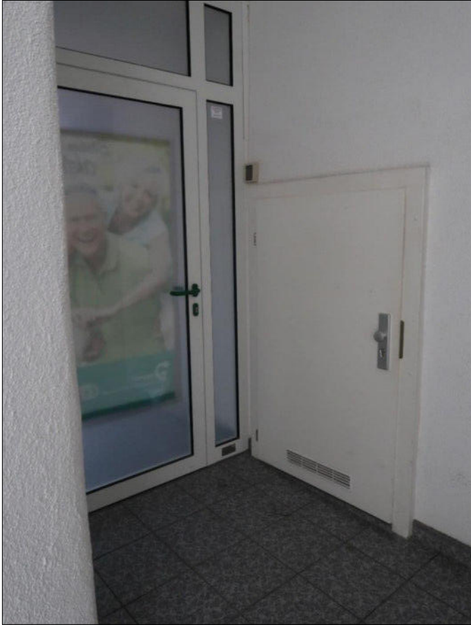
Bild 5: EG, Zugang zum Teileigentum Nr. 3 und rechts im Bild Zugang zu den Kellerräumen der ETW Nr. 1
