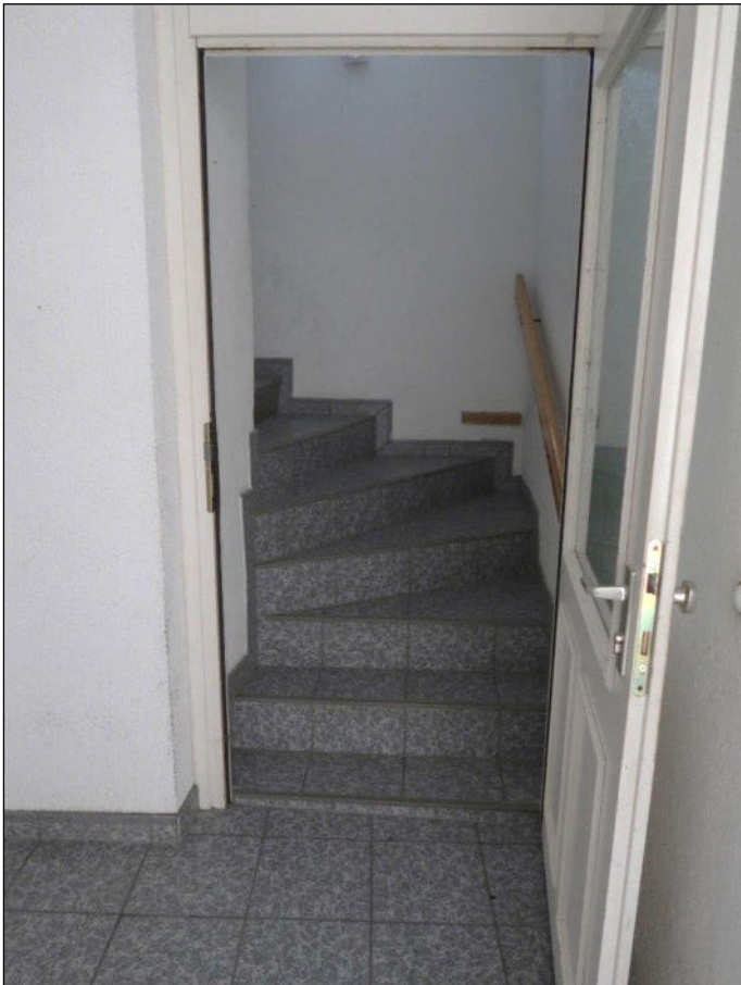
Bild 6: EG, Treppenaufgang ins 1. OG
