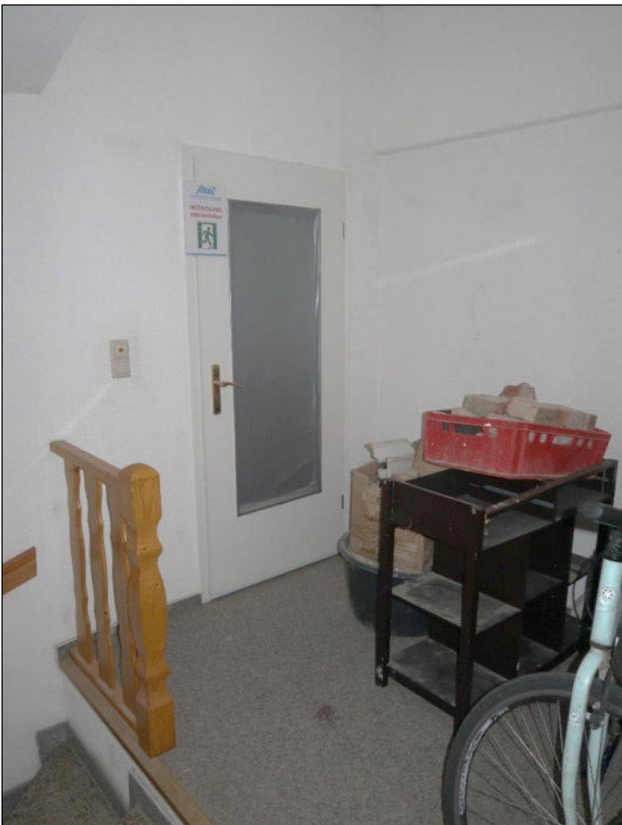
Bild 8: 1. OG, Gemeinschaftseigentum Treppenhaus (Zugang zum Teileigentum Nr. 3)
