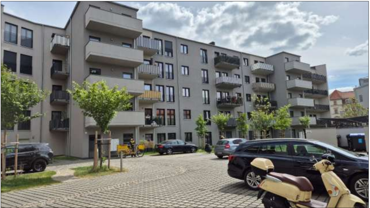
Foto 5: Blick in den Innenhof
