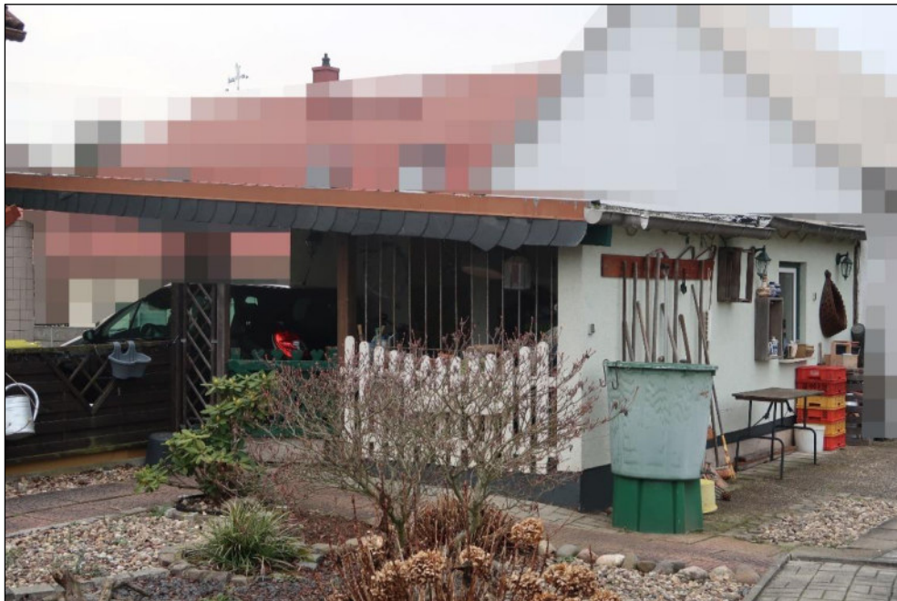
Bild 14: Seitenansicht und Rückansicht des Einzelcarports mit Einzelgarage (Überbau der Grundstücksgrenze durch den hinteren Gebäudeteil von Carport und Garage)
