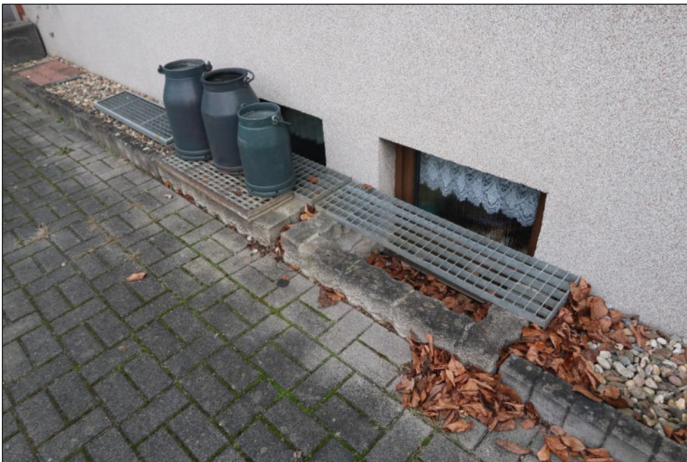
Bild 8: Kellerlichtschächte am Westgiebel
