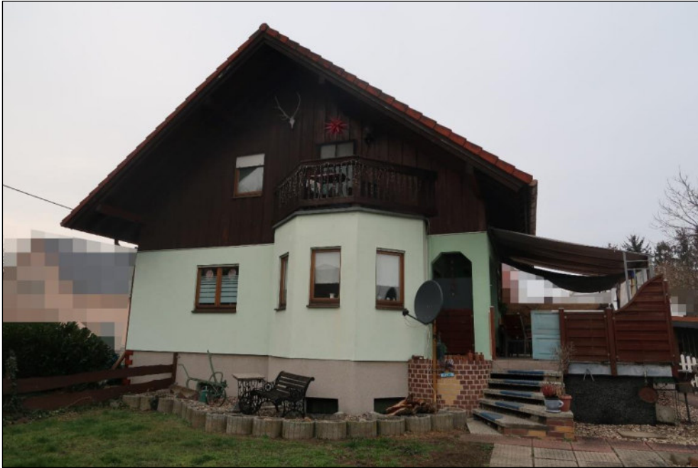
Bild 11: östliche Hausansicht mit Zugang zur Terrasse
