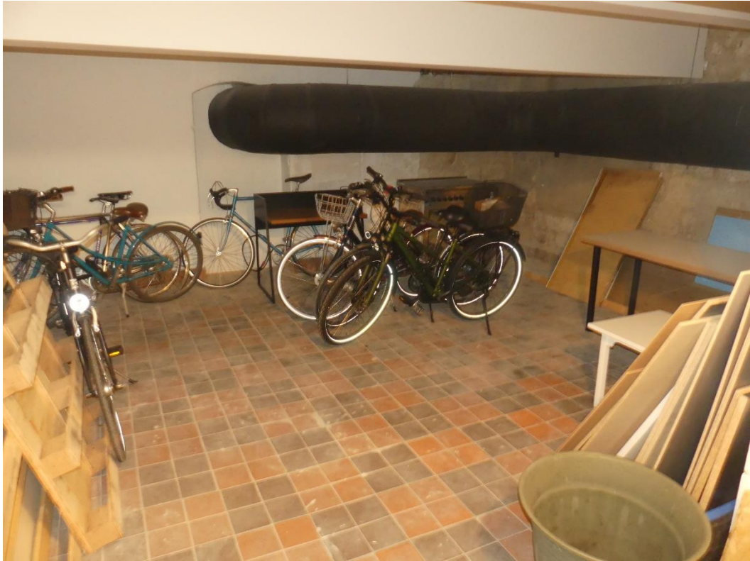
Foto 18: Fahrradabstellraum im Keller
