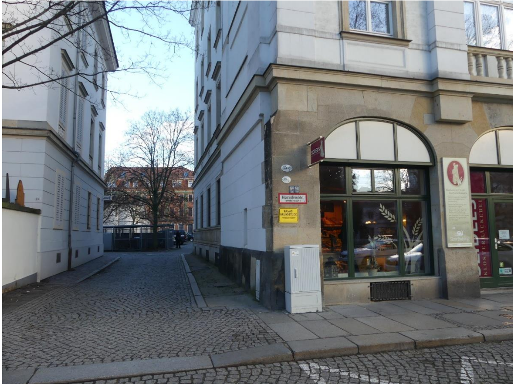
Foto 1: Straßenansicht und Zufahrt
