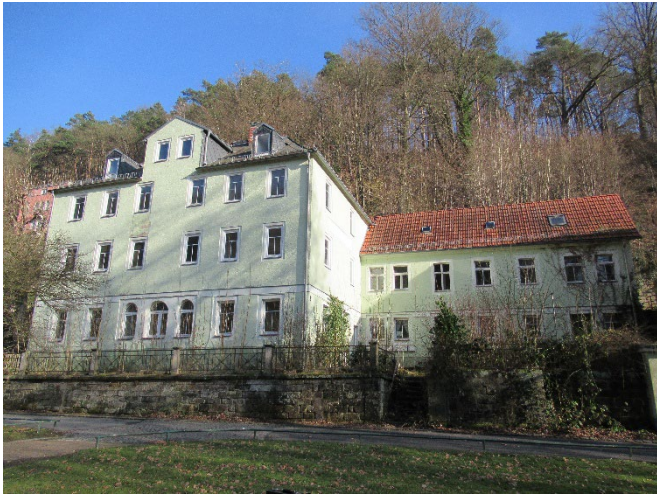
Foto 1: Ansicht des Gebäudes von der Badallee
