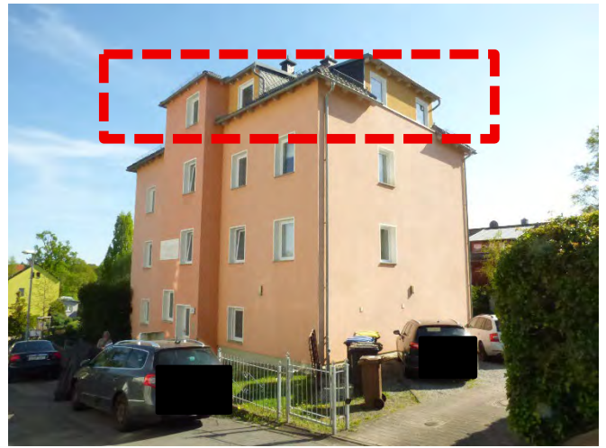
Foto 2: Ansicht von der Eibauer Straße mit rechtem Giebel und Lagekennzeichnung des Sondereigentums
