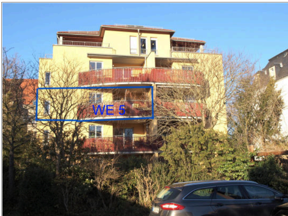
Abbildung 10: gartenseitige Rückansicht mit SE-Nr. 5 im 2. OG aus Richtung Südwest
