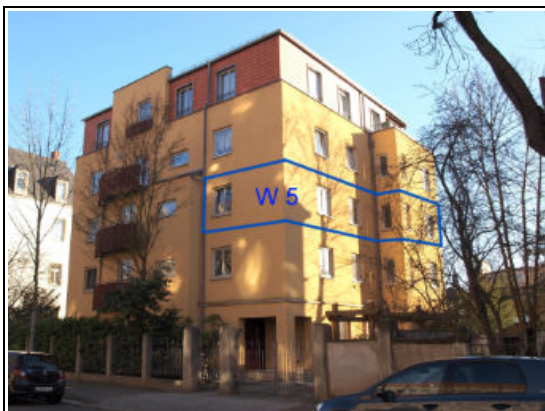
straßenseitige Ansicht mit SE-Nr. 5 im 2. OG rechts aus Richtung Norden
