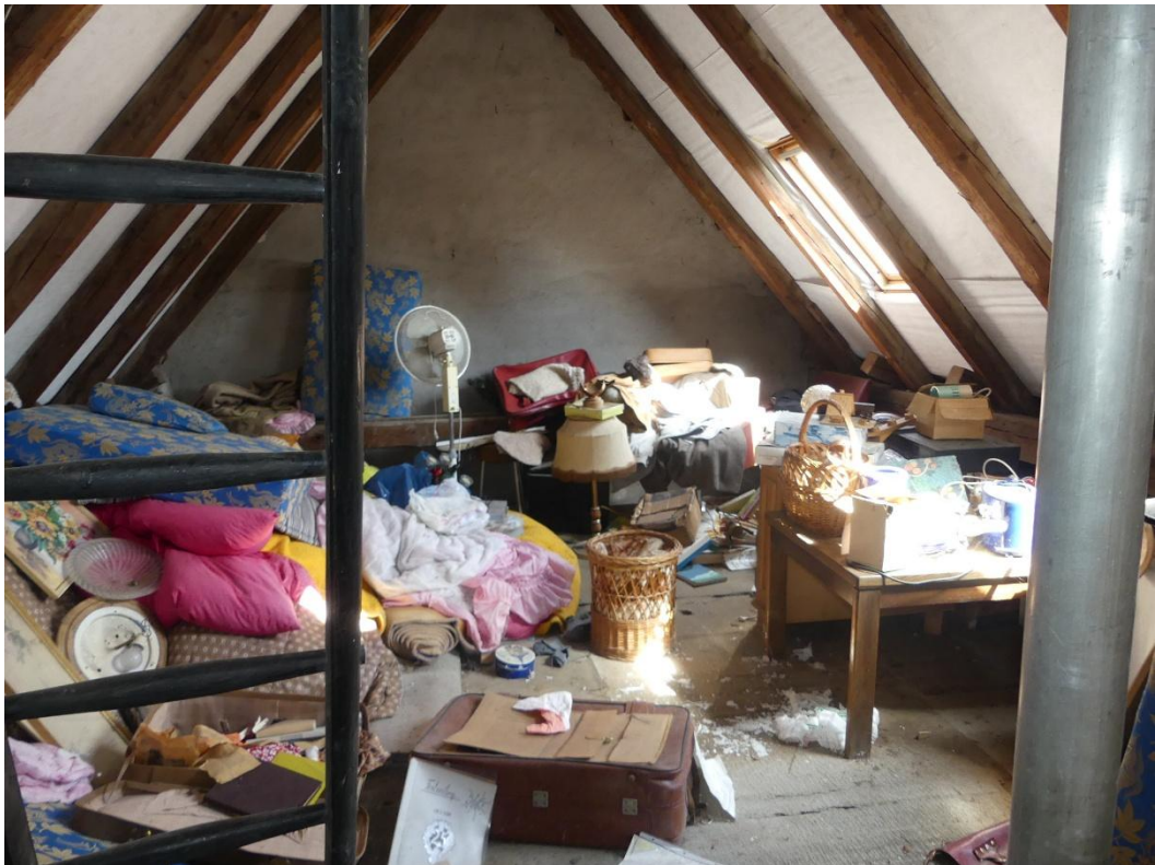
Foto 28: Dachboden (ungedämmt) im Dachgeschoss
