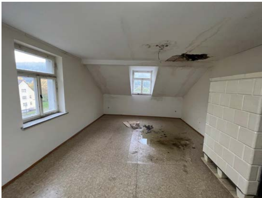
Dachgeschoss, Raum 1 – weiterer Dachschaten
