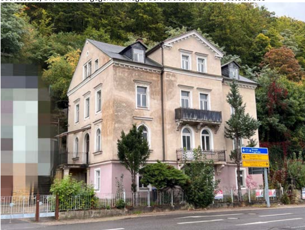
südwestliche Gebäudeecke; der Wasserschaden zeichnet sich an der Fassade deutlich ab
