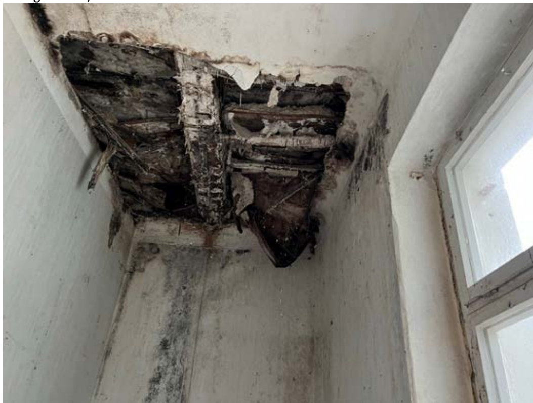
2.Obergeschoss; durchgebrochener Deckenbereich in Raum 3
