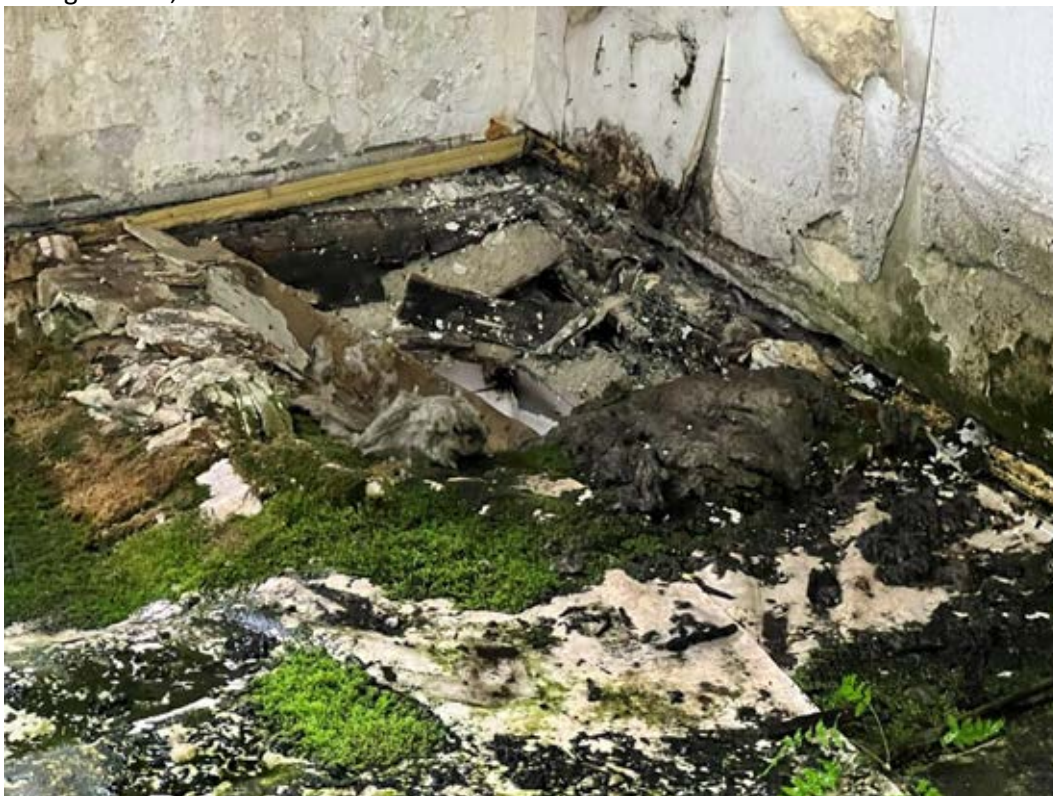
... die Decke zum darunter liegenden 2.Obergeschoss ist bereits durchgebrochen
