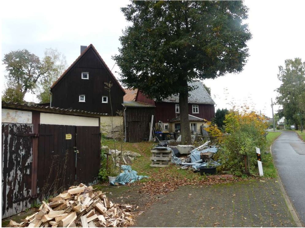
Foto 14: Doppelgarage (links) mit Wellasbestdeckung
