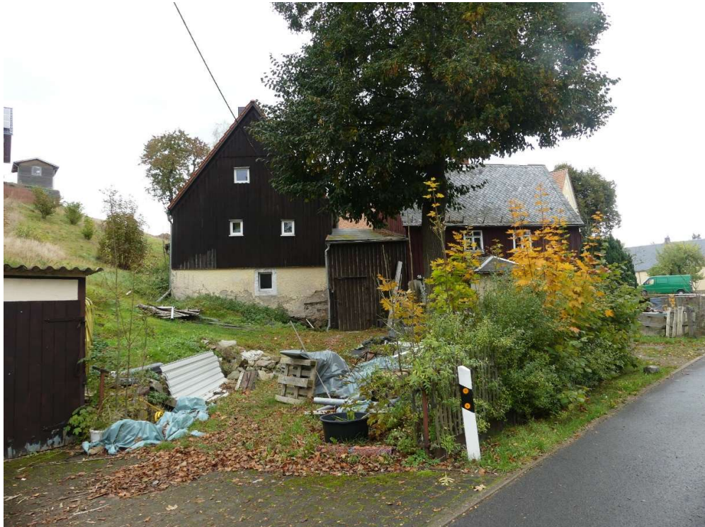
Foto 2: Westgiebel Hauptgebäude und Durchgang
