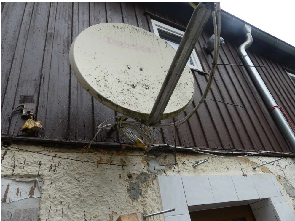
Foto 11: Detail Verbretterung Obergeschoss
