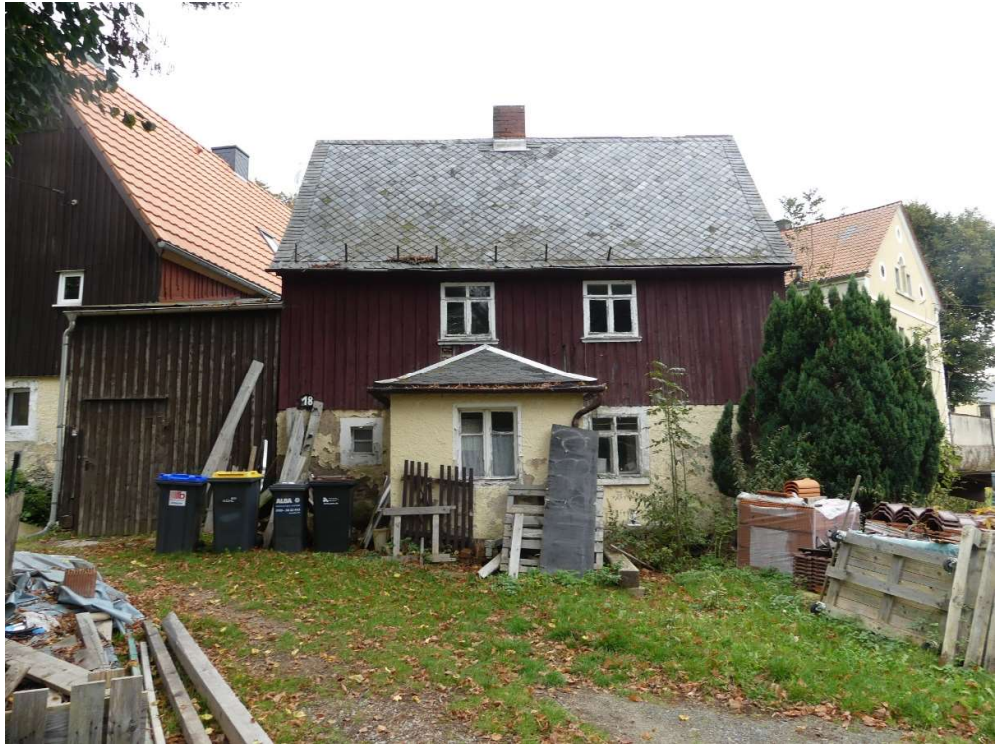
Foto 1: Straßenansicht Talweg (Nebengebäude)
