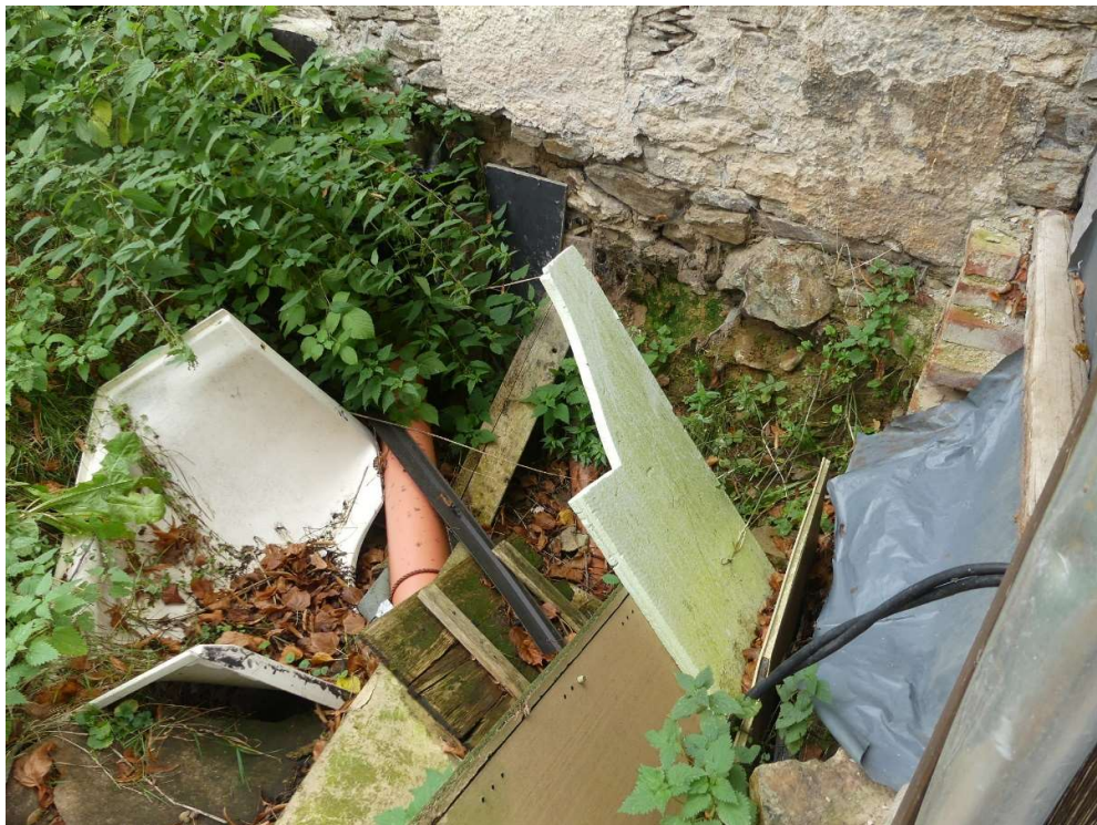
Foto 4: erneuerte Abwasserleitung zum Hauptgebäude
