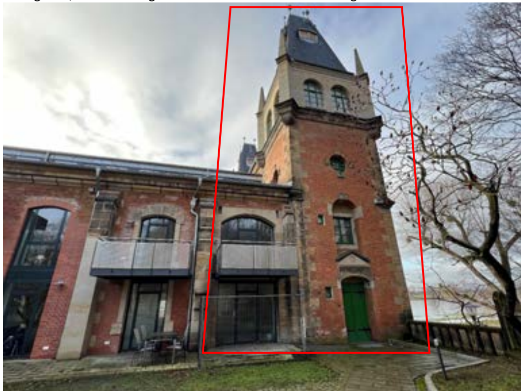
Blick aus nördlicher Richtung; die Lage der Wohnung Nr. 1 ist markiert
