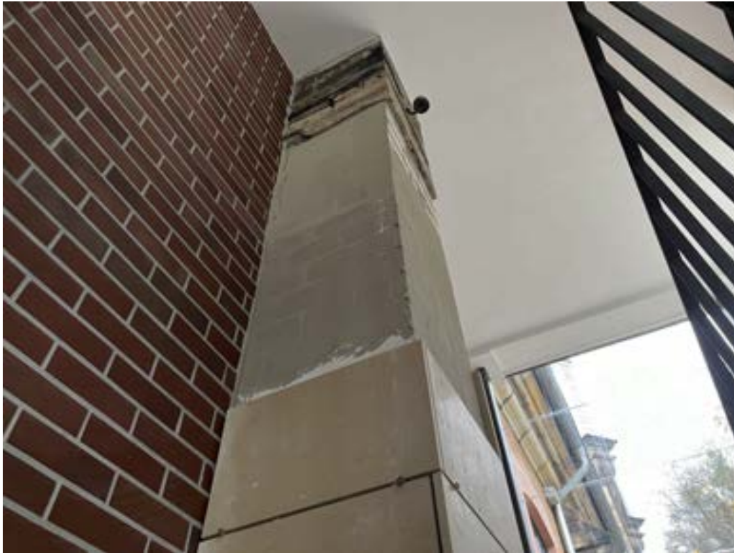
fehlende Sandsteinverkleidungen
