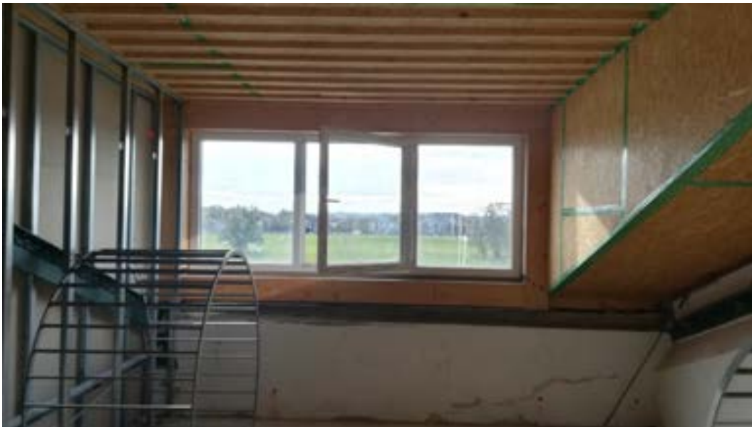
von der WEG-Verwaltung übersandte Innenaufnahme (Aufnahmedatum: 05.11.2019); das Bild müsste das Fenster Richtung Elbe im 2.Obergeschoss zeigen
