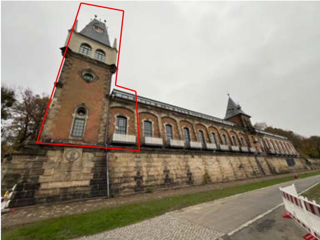
Blick aus südwestlicher Richtung über den Körnerweg (Elbradweg)
