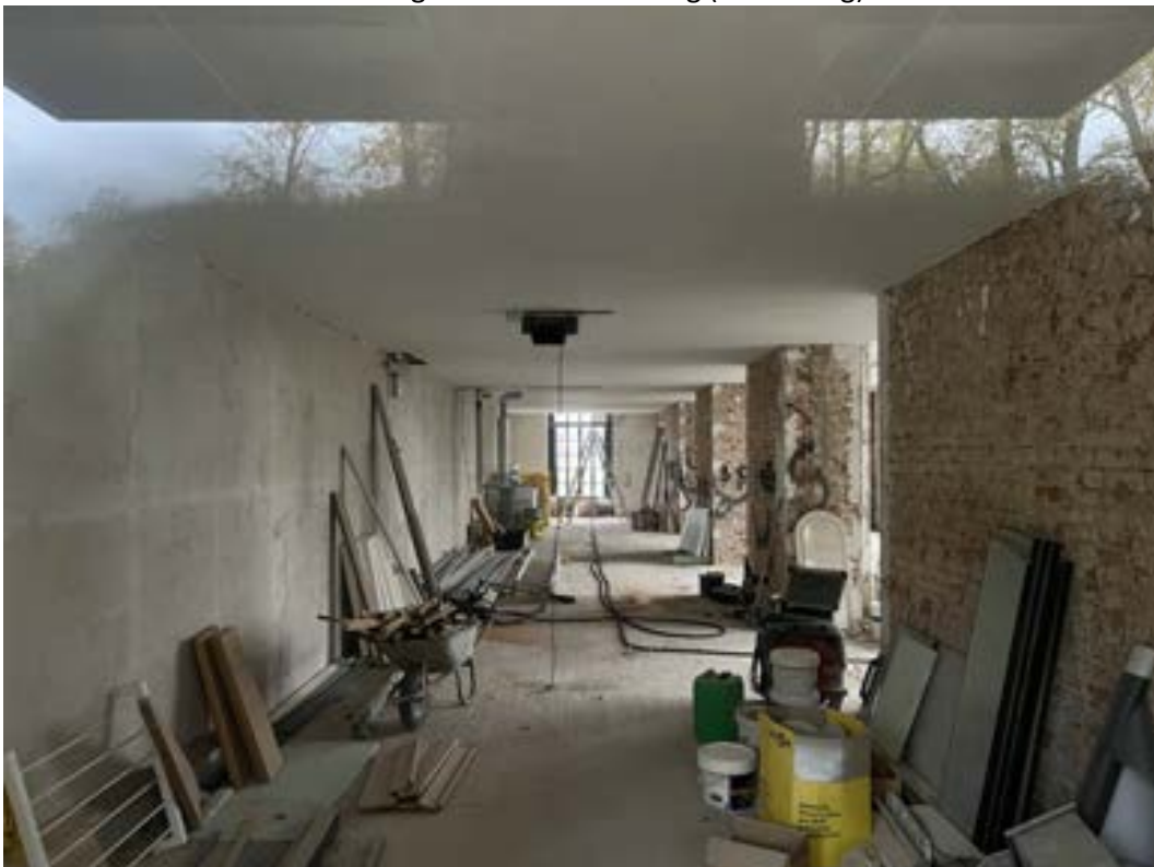
Wohnung Nr. 1; Blick durch das Terrassenfenster im Erdgeschoss an der Nordseite
