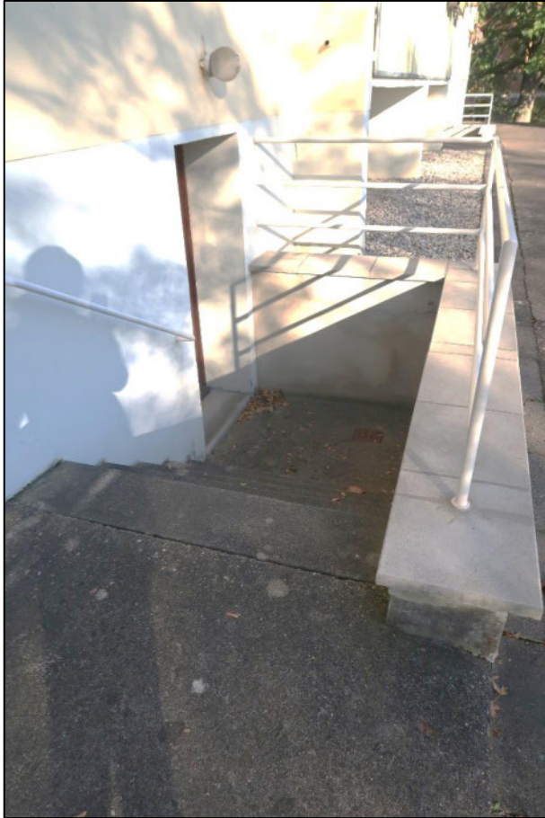
Bild 5: Kelleraußentreppe Marienhofstraße 4b
