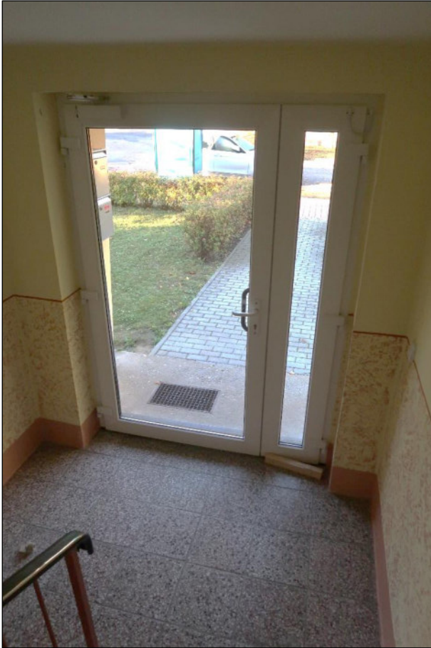
Bild 9: Hauseingang Marienhofstraße 4b
