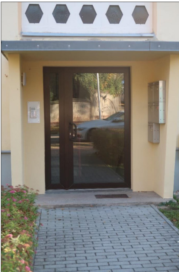
Bild 2: straßenseitiger Hauseingang der Marienhofstraße 4b
