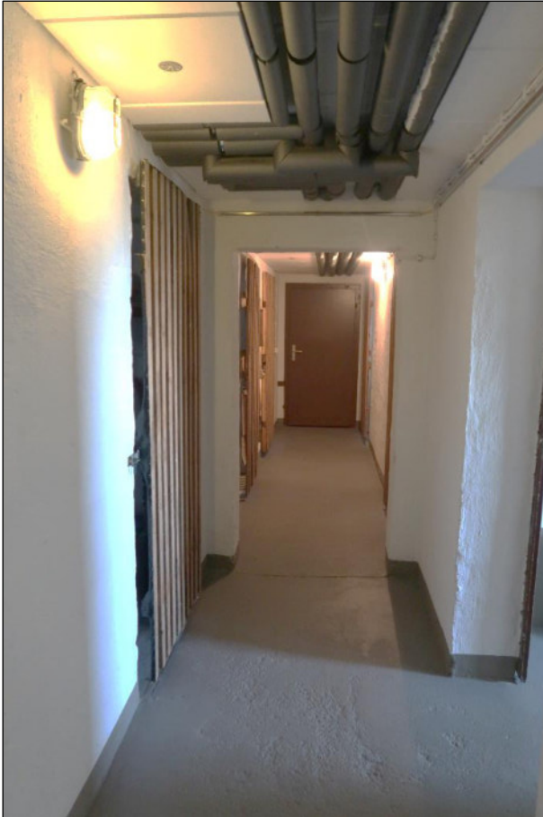
Bild 11: Marienhofstraße, Keller, Flur links
