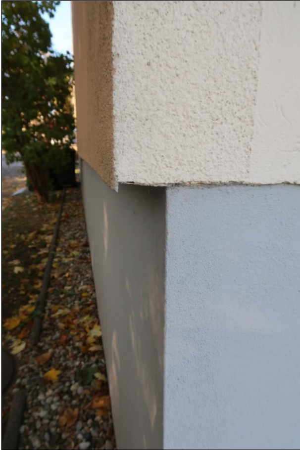
Bild 7: Detailansicht der WDVS-Dämmung am Gebäude Marienhofstraße 4a/4b
