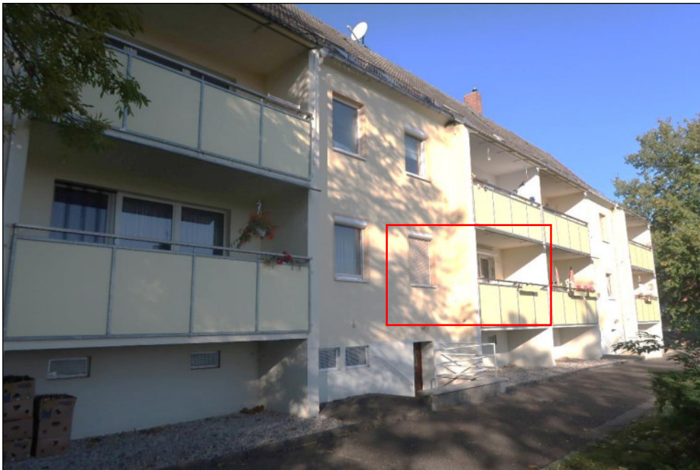
Bild 4: Gebäuderückseite Marienhofstraße 4a/4b mit Kennzeichnung ETW Nr. 6
