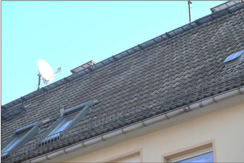
Bild 3: Detailansicht der Dacheindeckung
