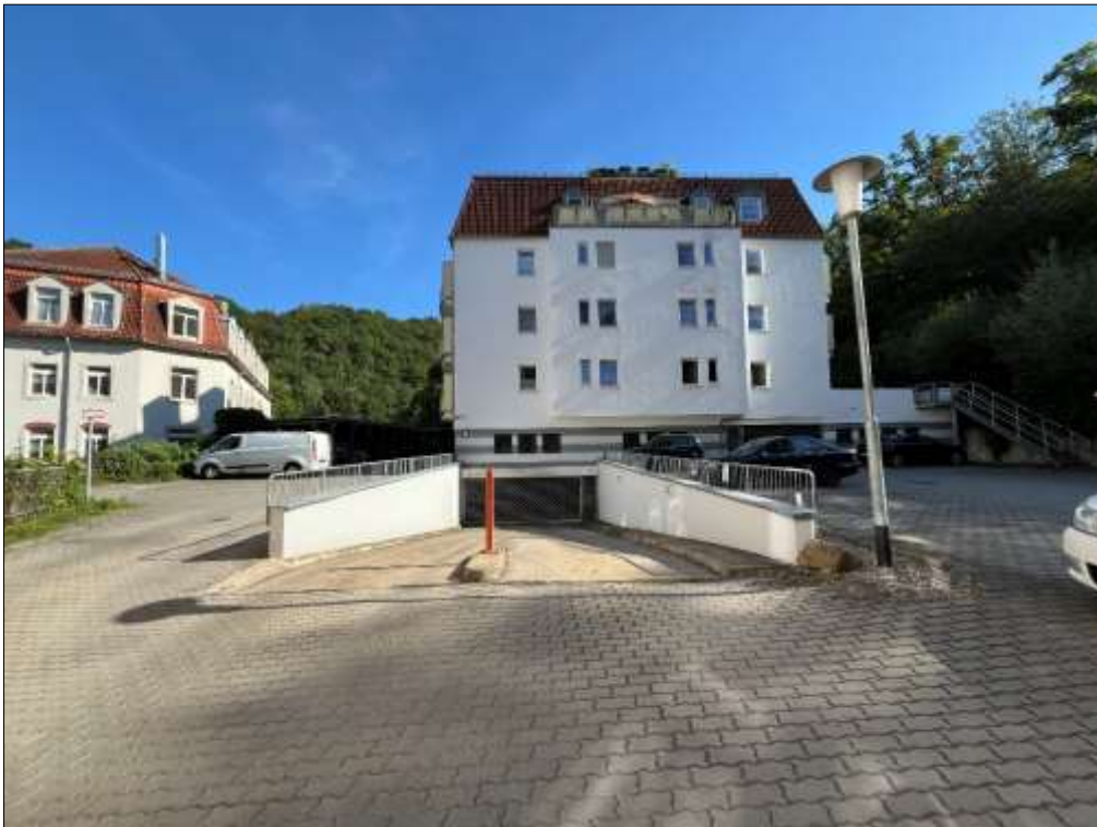
FOTO 3: Gebäude 123 a mit Einfahrt zur Tiefgarage
