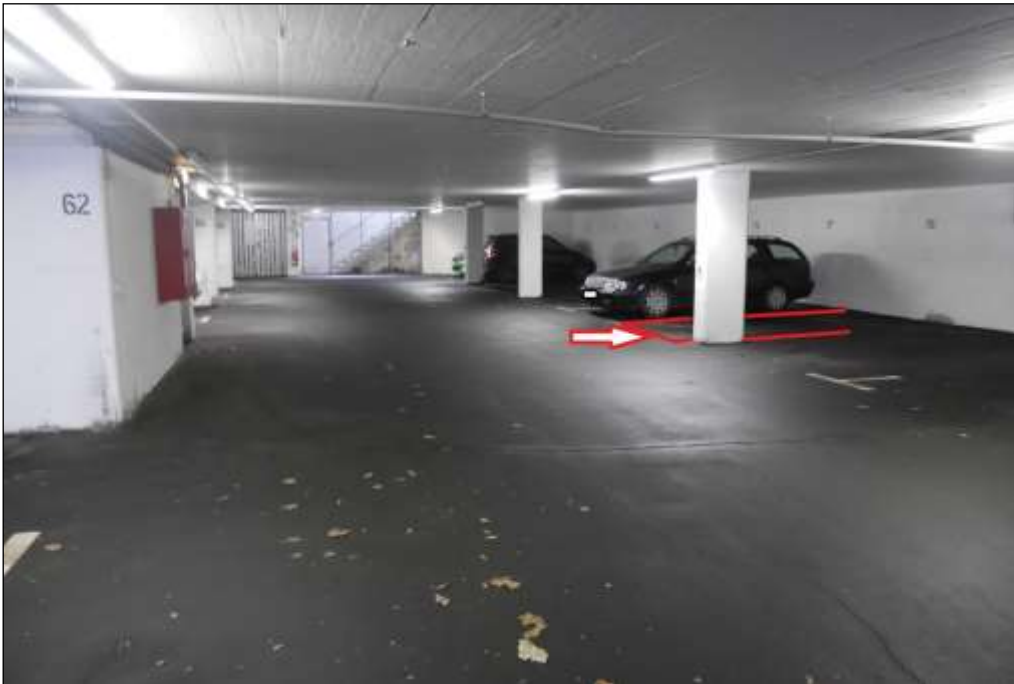
Foto 7: Blick in die Tiefgarage
