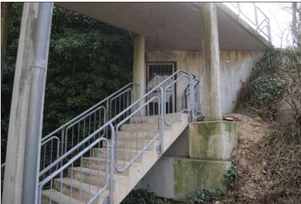
Foto 6: Zugang von Haus K zu Haus A in die Tiefgarage
