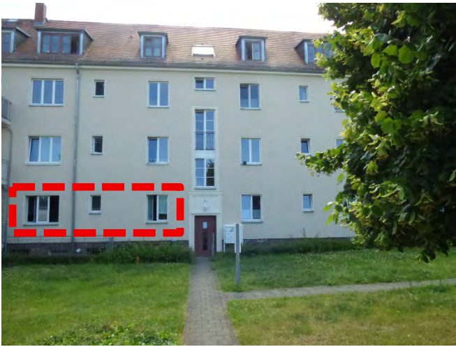
Foto 1: Lage des Sondereigentums auf der Hofseite Aufgang Boltenhagener Str. 84
