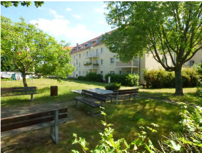
Foto 3: Teilbereich der Außenanlagen auf Rückseite
