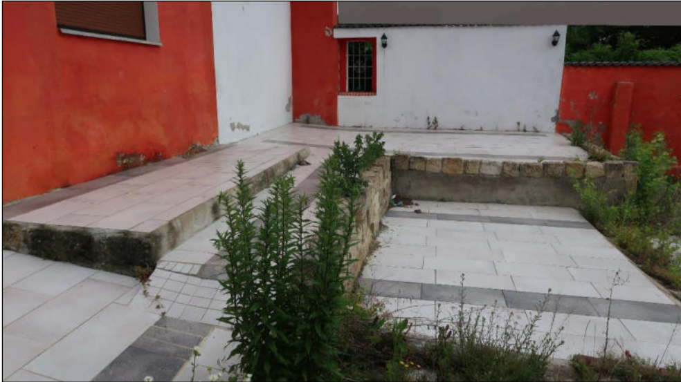
Bild 4: Grundmauern der ehem. Anbauten am Gebäude
