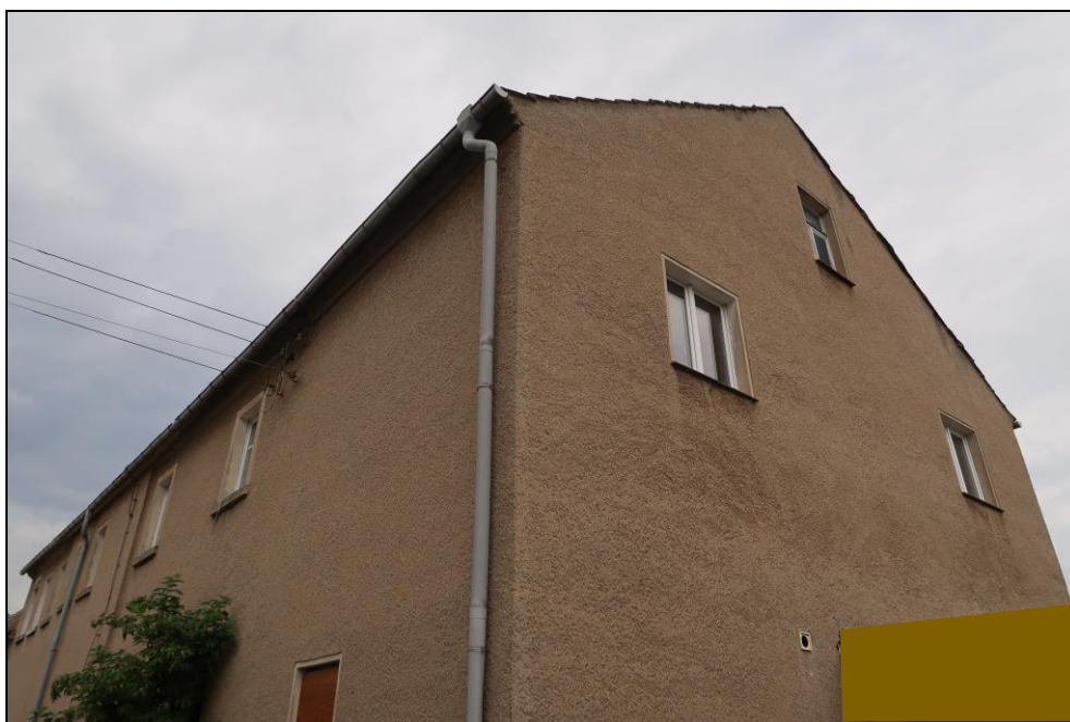
Bild 8: Ostgiebel des ehem. Wohn- und Geschäftshauses
