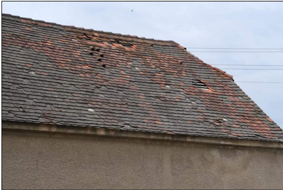
Bild 3: Detailansicht der Dacheindeckung des Wirtschaftsanbaus
