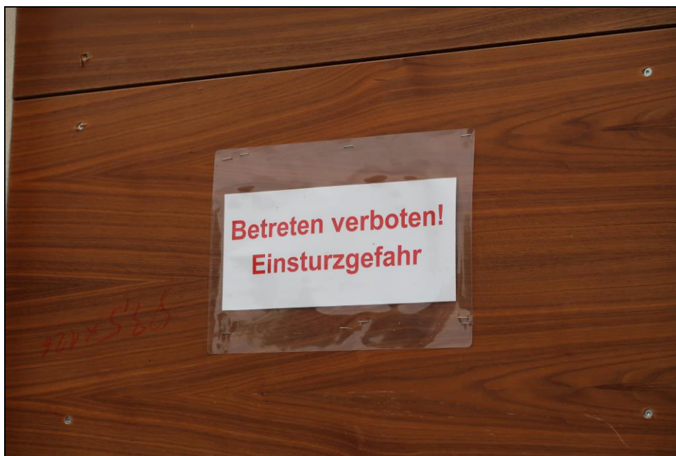
Bild 11: Warntafel am Gebäude
