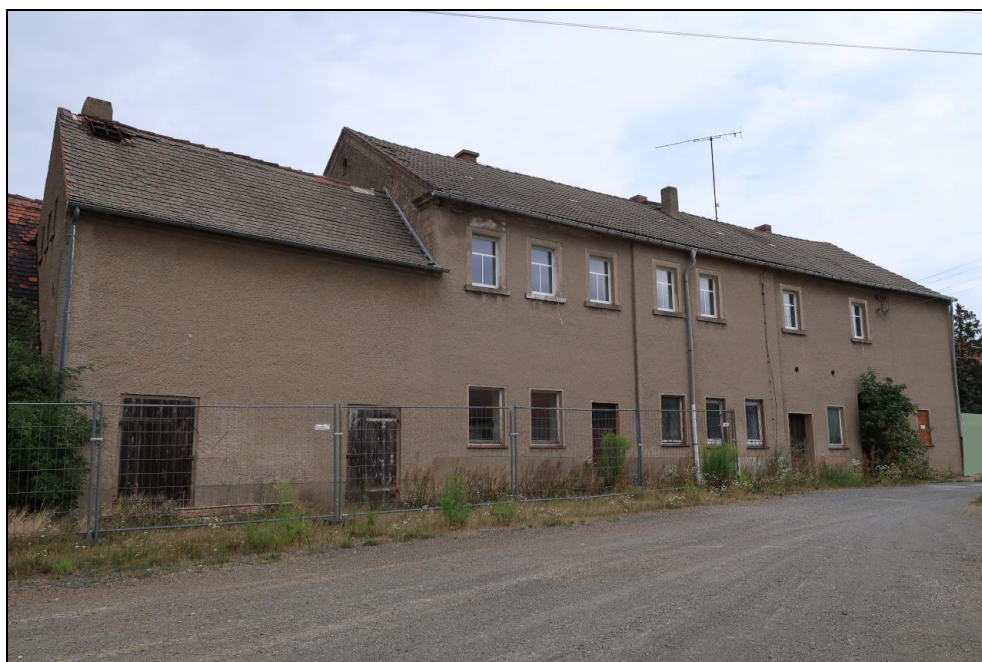
Bild 6: Hofansicht des ehem. Wohn- und Geschäftshauses
