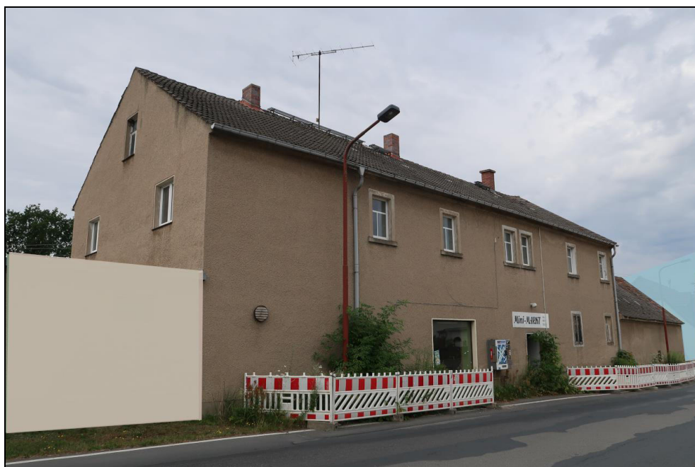
Bild 1: Straßenansicht des ehem. Wohn- und Geschäftshauses
