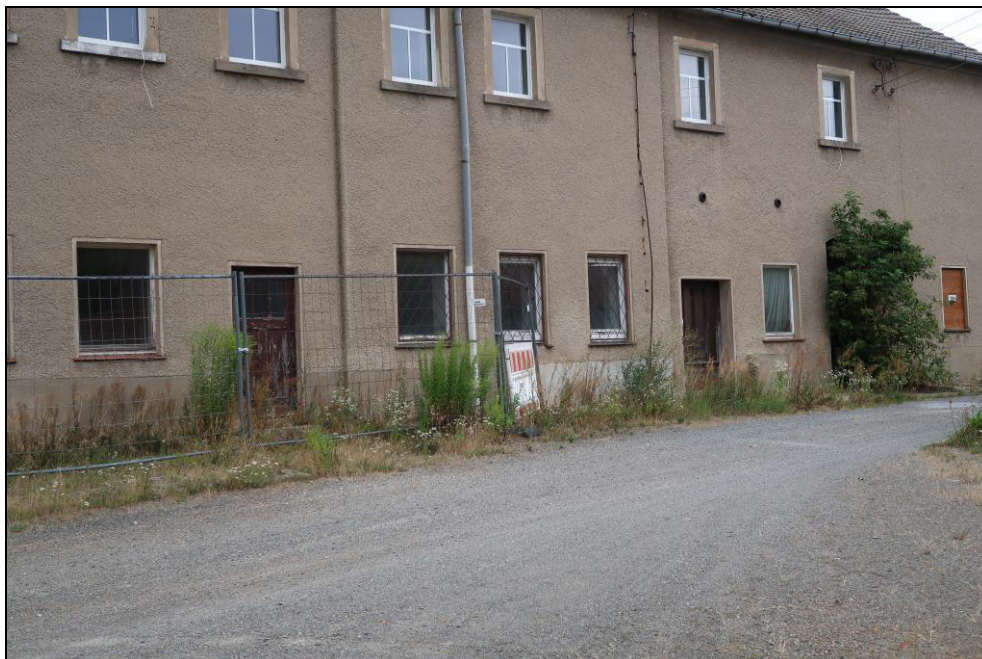
Bild 7: Hofansicht des ehem. Wohn- und Geschäftshauses
