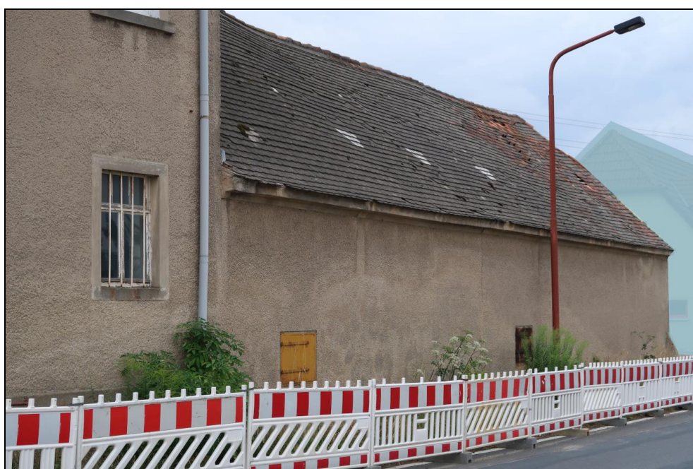
Bild 2: Straßenansicht des Wirtschaftsbaus
