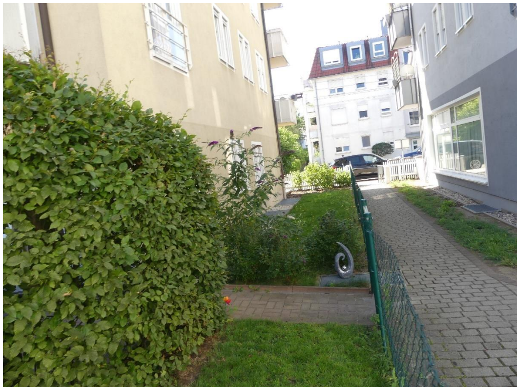
Foto 12: neben der Terrasse wurde ein Gartenanteil der Wohnung Nr. 57 zugeordnet
