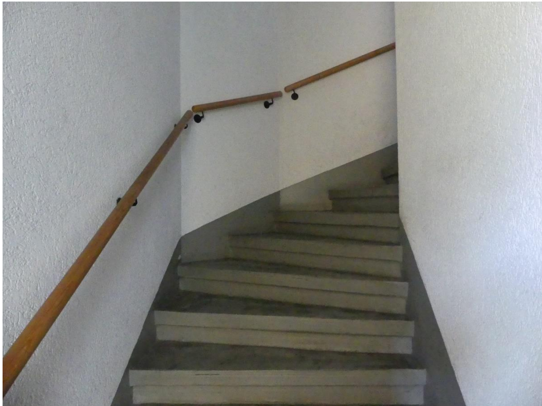
Foto 7: Treppenhaus von innen
