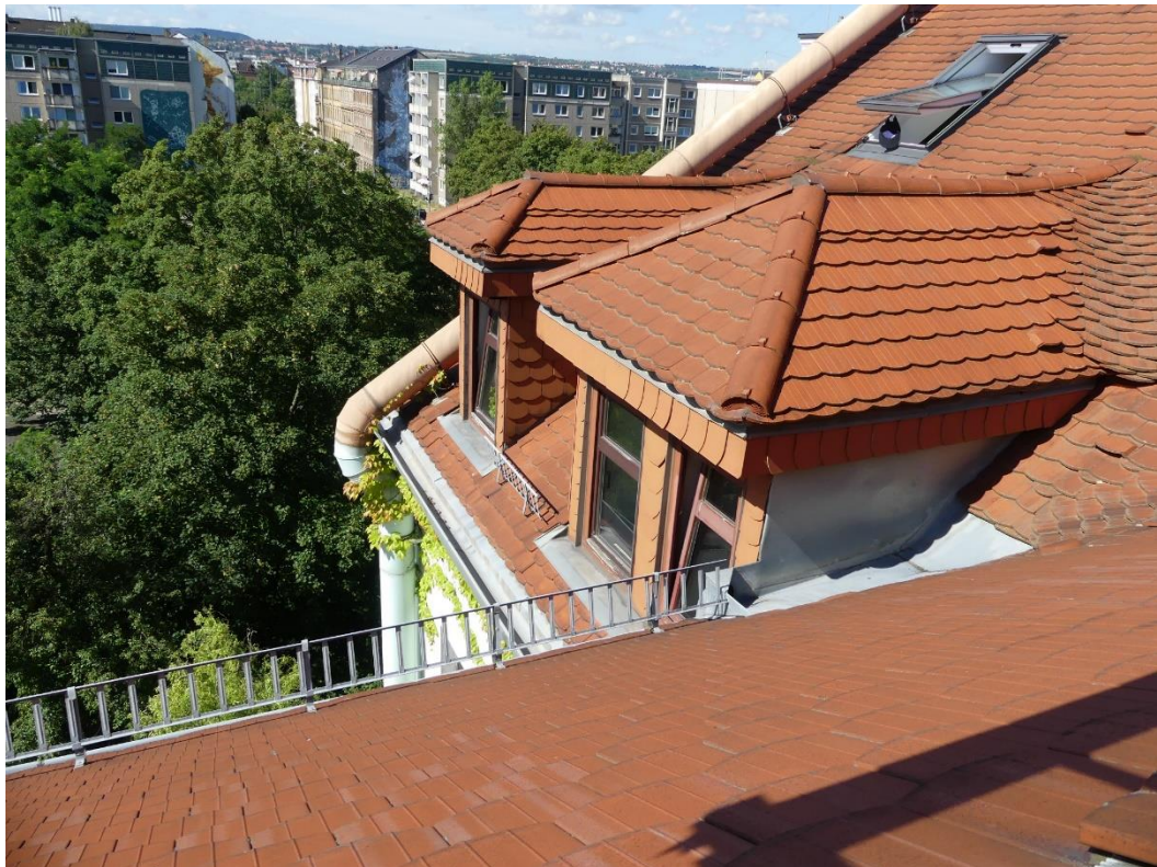
Foto 20: Blick auf die Dachlandschaft
