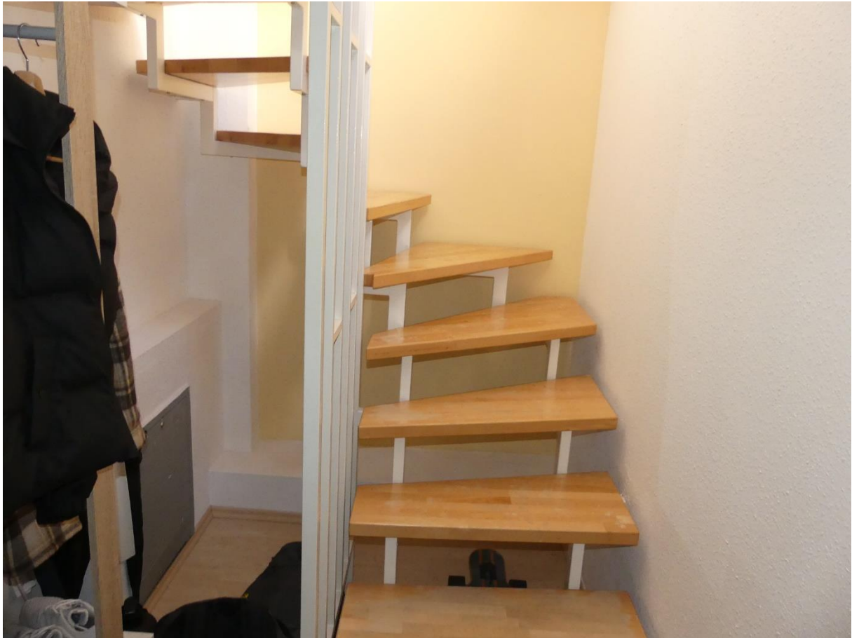
Foto 18: Aufgang zum Dachgeschoss
