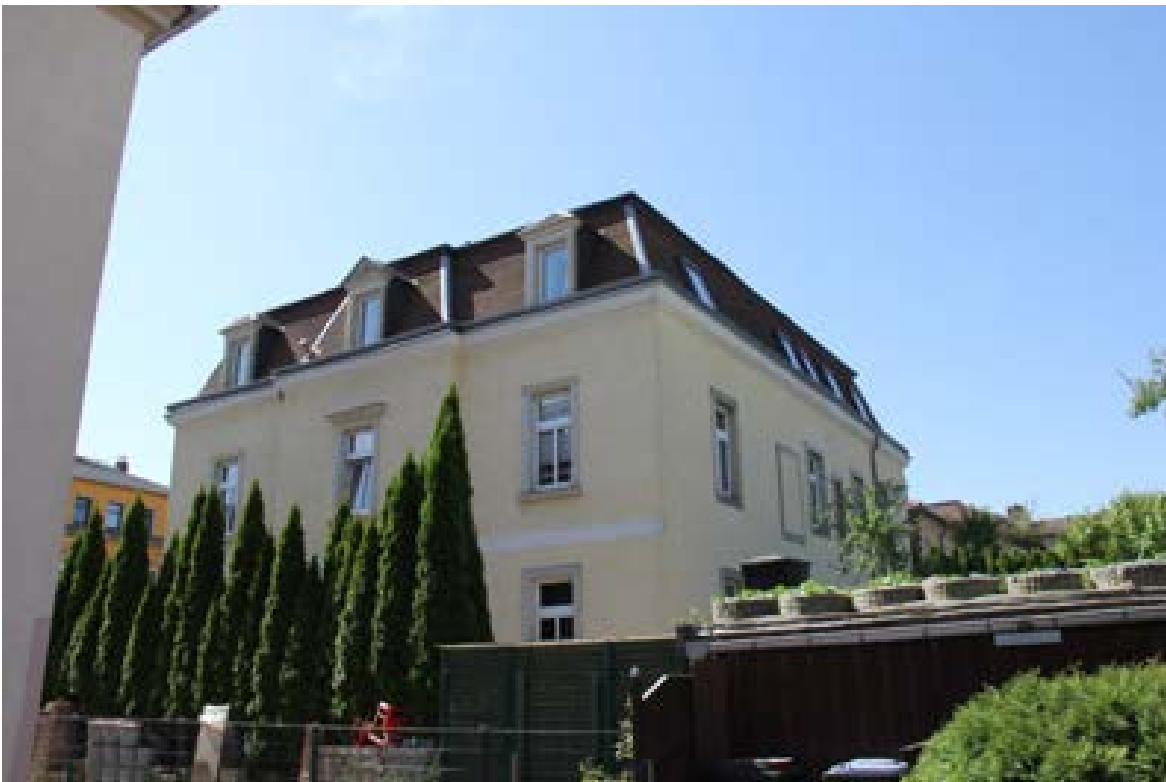
Nordfassade (Aufnahme aus 2022)
