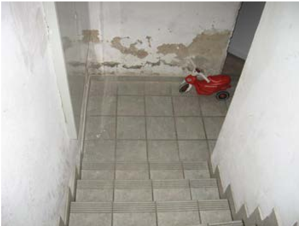
Treppe zum Keller (Aufnahme aus 2009)
