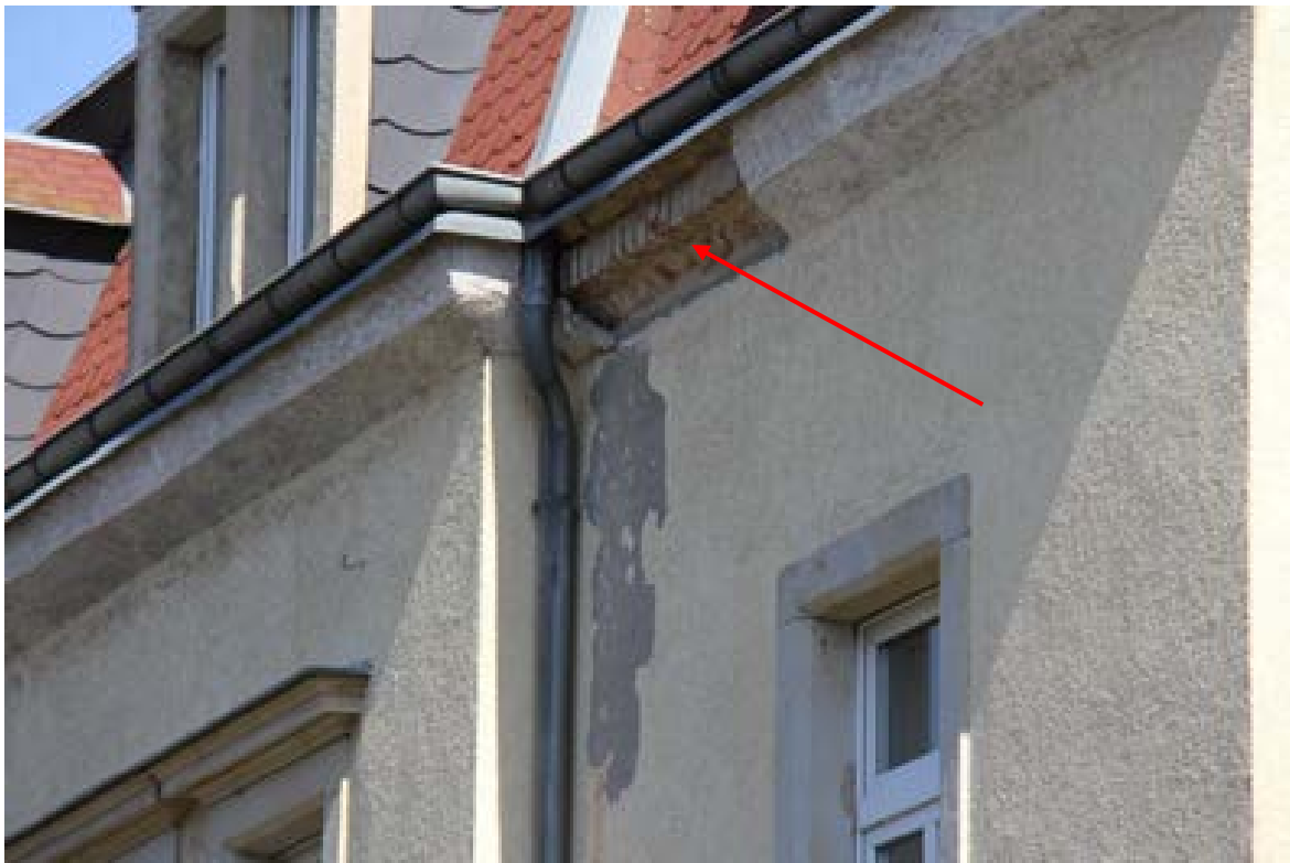
Detail Putzschaden am Fallrohr (Aufnahme aus 2022)
