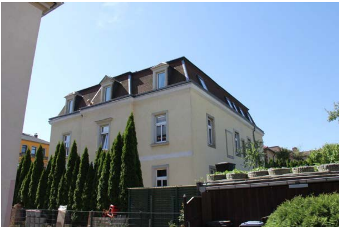
Nordfassade (Aufnahme aus 2022)
