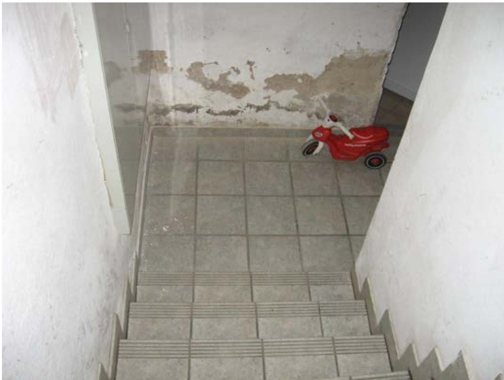
Treppe zum Keller (Aufnahme aus 2009)
