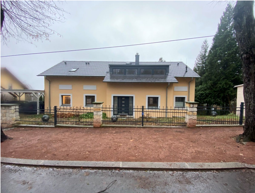
Straßenfassade zur Terrassenstraße (Nordseite)
