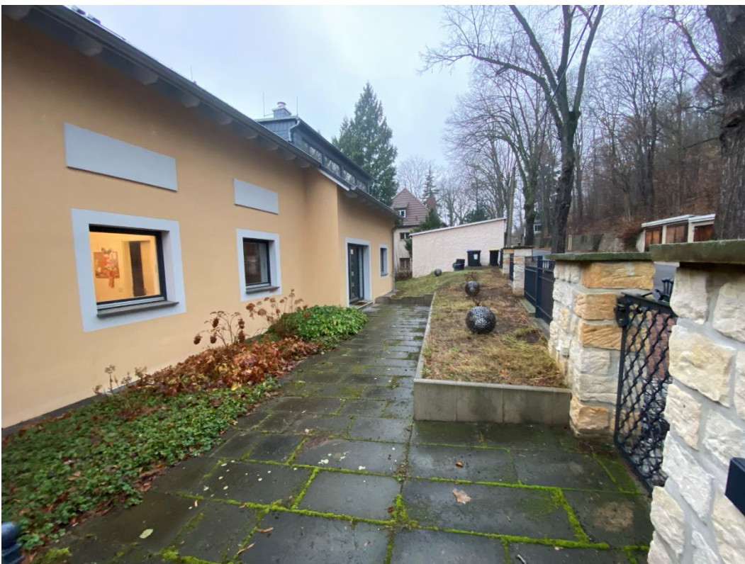
Zugang/Wegbefestigung zum Hauseingang
