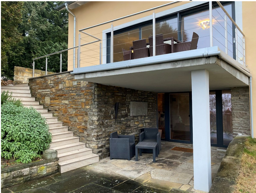
überdachte Terrasse im Kellergeschoss und Terrasse/Balkon im Erdgeschoss darüber
