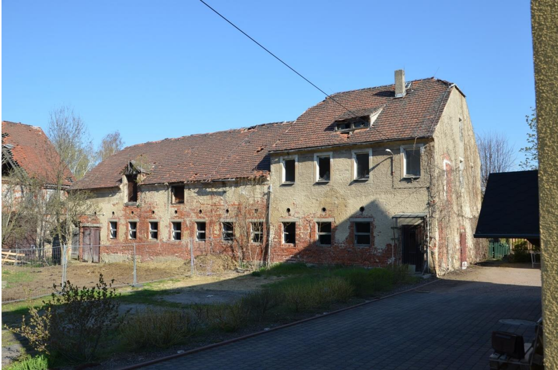
Bild 1: Stallgebäude, OG des rechten Gebäudeteils früher offensichtlich zu Wohnzwecken genutzt
