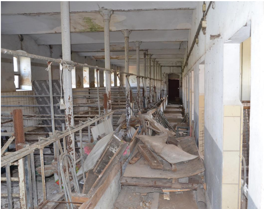
Bild 2: Teilansicht Erdgeschoss des Stallgebäudes
