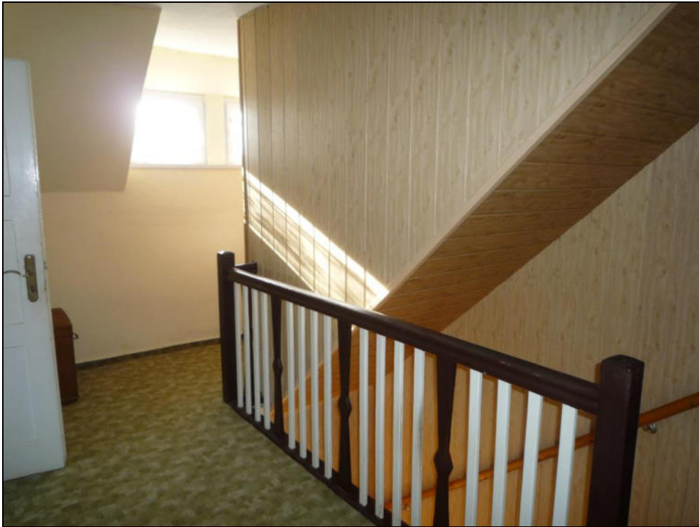
Bild 27: Wohnhausanteil, Diele und Geschosstreppe zum Spitzboden
