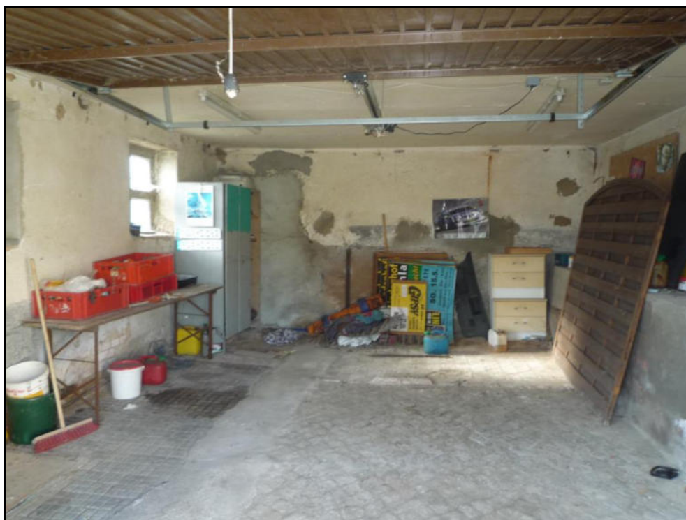
Bild 7: Blick in die linke Garage des Scheunengebäudes
