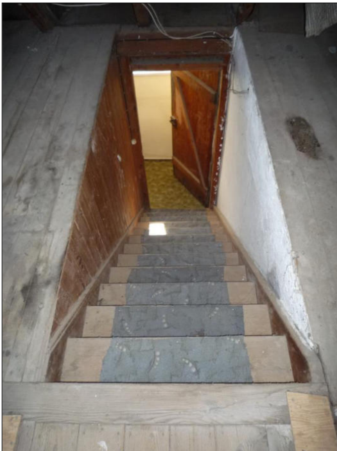
Bild 32: Wohnhausanteil, Treppe zum Spitzboden
