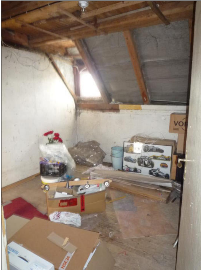
Bild 31: Wohnhausanteil, DG, Bodenkammer
