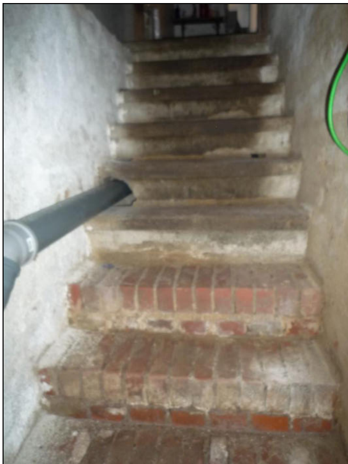
Bild 15: Wohnhausanteil, Treppe zum Keller
