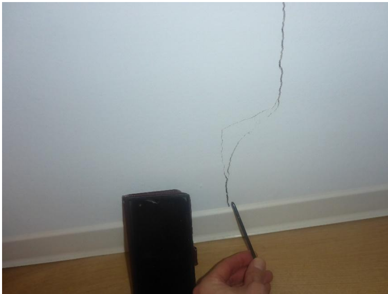
Treppenförmiger Riss
