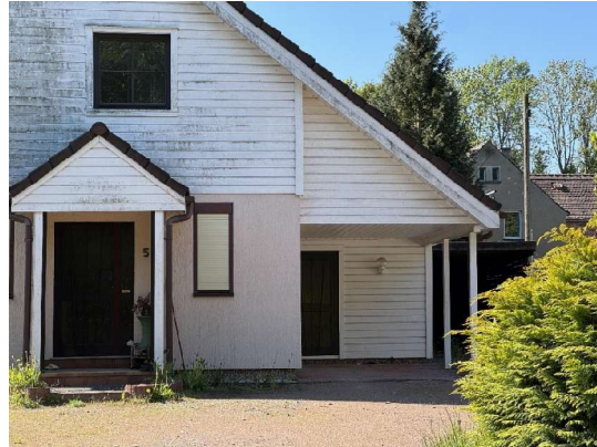
Eingangstür und Carport
