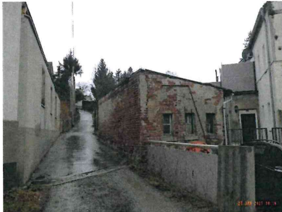
Nebengebäude und Zufahrt zu den Hinterliegern
