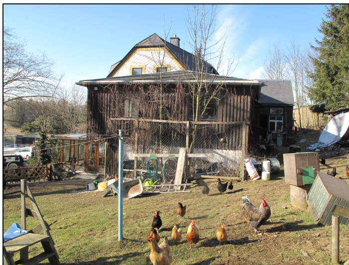
Blick auf den Südostgiebel des Wohnhauses und den holzverkleideten Anbau
