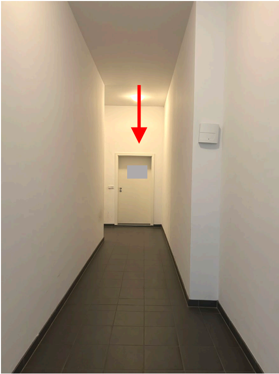
Abb. 05 Erdgeschoss, Teilansicht Hausflur und Ansicht Eingang zur Büroeinheit BE 14
