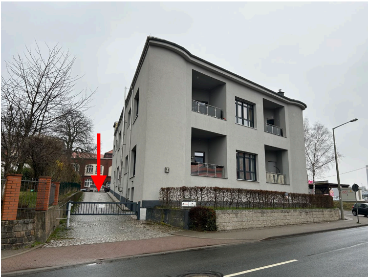
Abb. 02 Ansicht des Gebäudes von der Frauensteiner Straße aus mit Grundstückszugang/ Grundstückszufahrt, Südwesten
