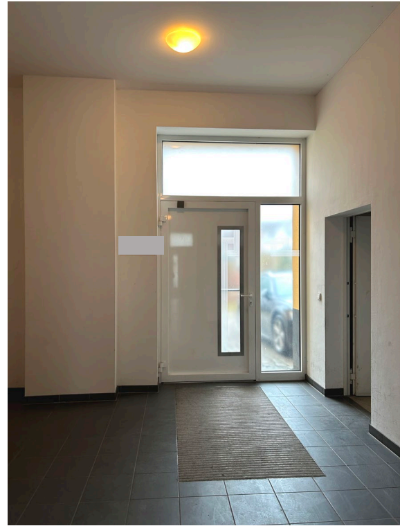
Abb. 06 Erdgeschoss, Teilansicht Hausflur und Blick auf die Haupteingangstür
