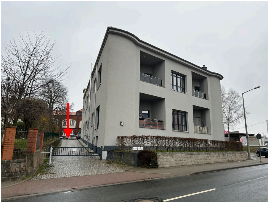
Abb. 02 Ansicht des Gebäudes von der Frauensteiner Straße aus mit Grundstückszugang/ Grundstückszufahrt, Südwesten
