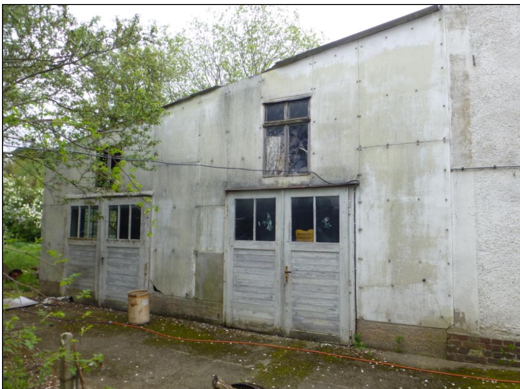
Foto 3 Teilansicht Wohnhaus und Anbauten (Lager, Werkstatt) – Westseite
