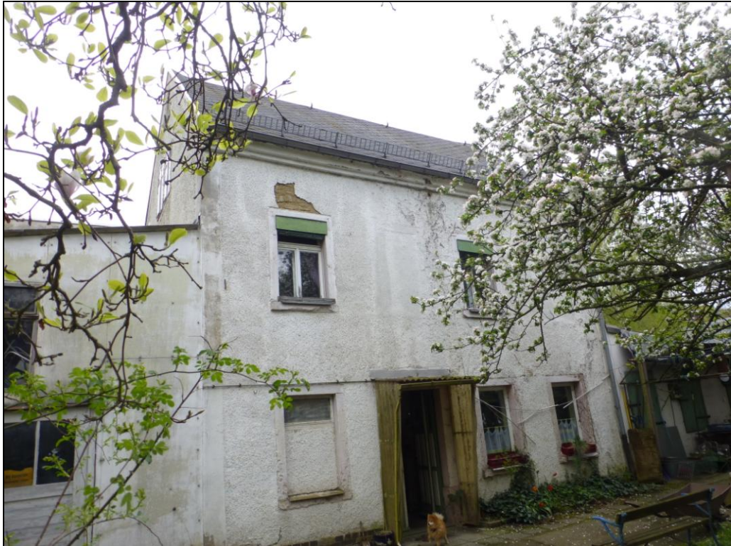
Foto 2 Teilansicht Wohnhaus und Anbauten – Westseite
