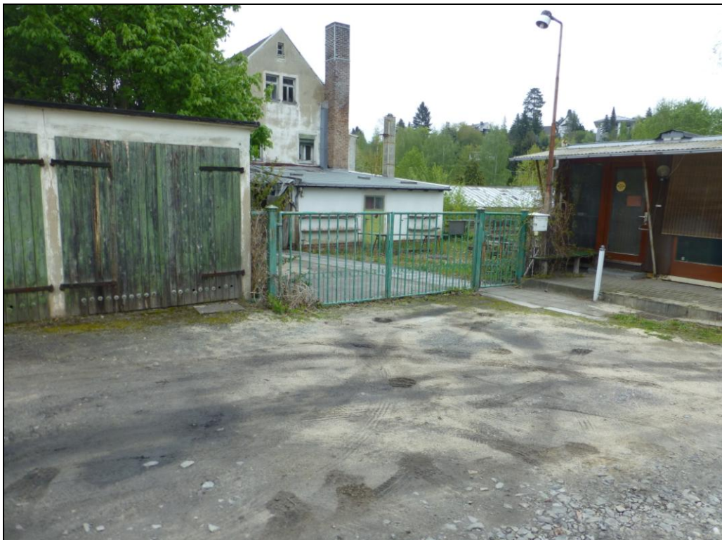
Foto 7 Ansicht Wohnhaus und Anbauten, Garagengebäude und Verkaufscontainer
