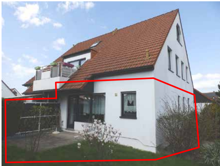
Bild 12: Ansicht der Südseite des Dreifamilienhauses (mit Kennzeichnung der Lage der Wohnung 1 mit zugehöriger Terrasse))
