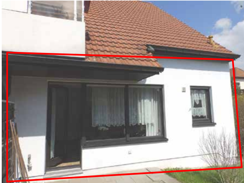
Bild 13: Ansicht der Südseite des Dreifamilienhauses (mit Kennzeichnung der Lage der Wohnung 1)
