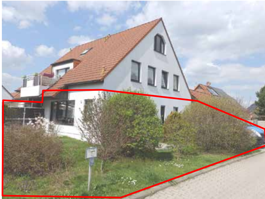
Bild 1: Straßenansicht des Dreifamilienhauses (mit Kennzeichnung der Lage der Wohnung 1 mit zugehöriger Terrasse, Gartenfläche und Kfz-Stellplatz)
