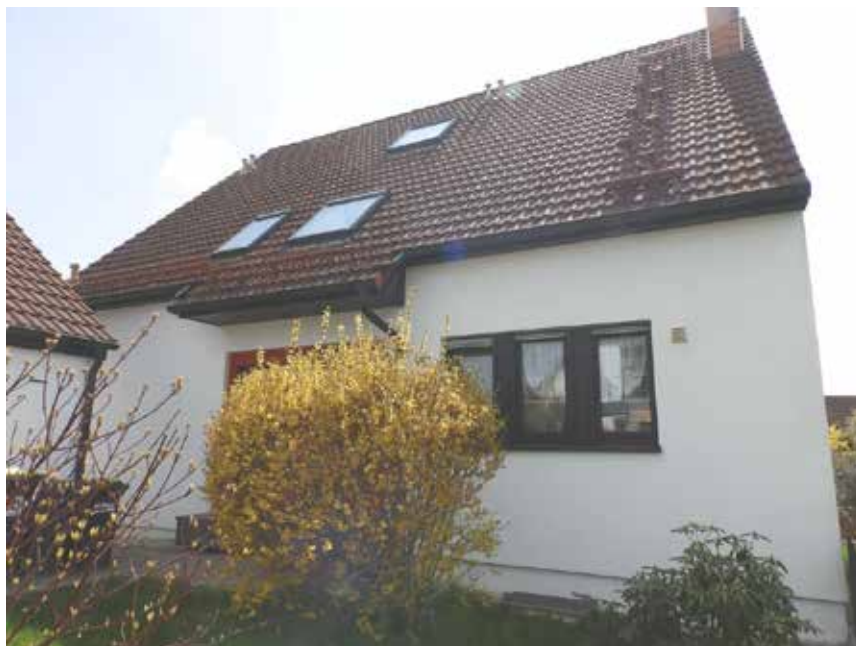
Bild 4: Ansicht des Dreifamilienhauses aus nördlicher Richtung
