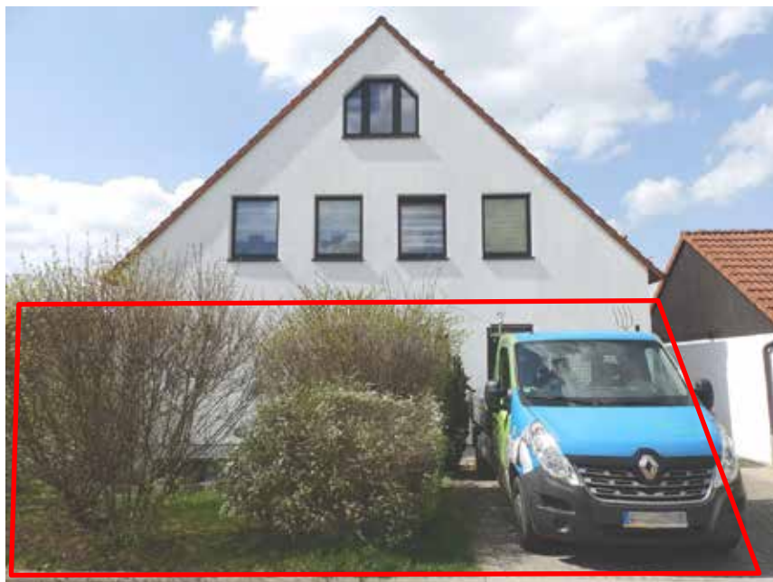
Bild 2: Straßenansicht des Dreifamilienhauses (mit Kennzeichnung der Lage der Wohnung 1 mit zugehörigem Kfz-Stellplatz und Gartenfläche)
