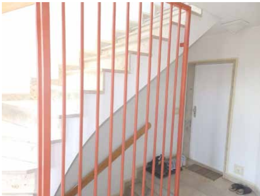
Bild 6: Treppenhaus des Dreifamilienhauses (mit Zugang zu Wohnung 1)
