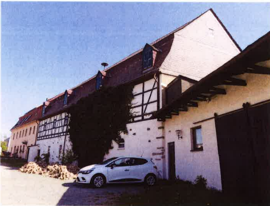
Bild 2: Flurstück 567/9 Hinteransicht vom Hof Wirtschaftsgebäude mit Anbau „Alte Futterhaus“
