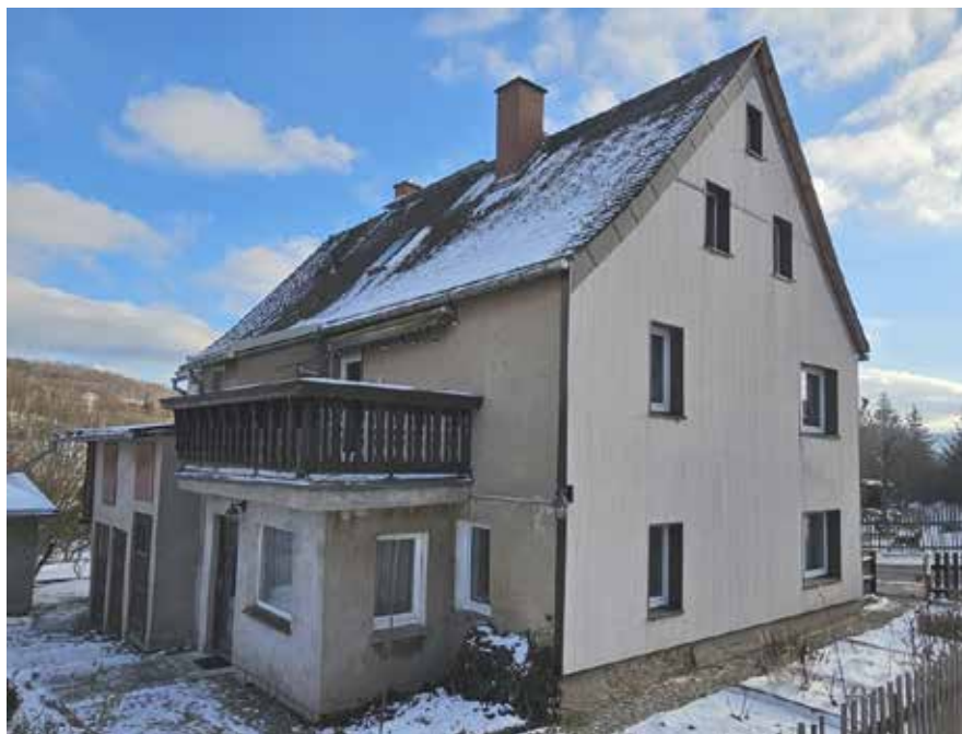
Bild 2: Ansicht des Zweifamilienhauses von der Grundstücksgrenze aus
