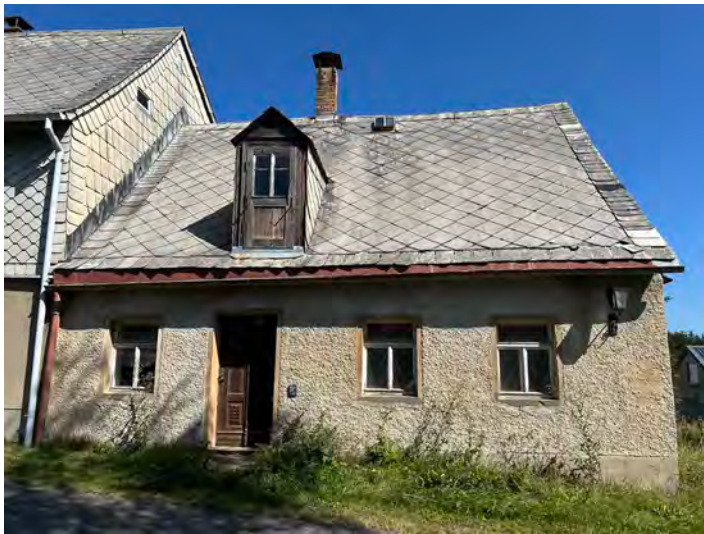
Abb. 02 Flnr. 9, Straßenansicht des Wohngebäudes mit Hauseingang, Südwesten
