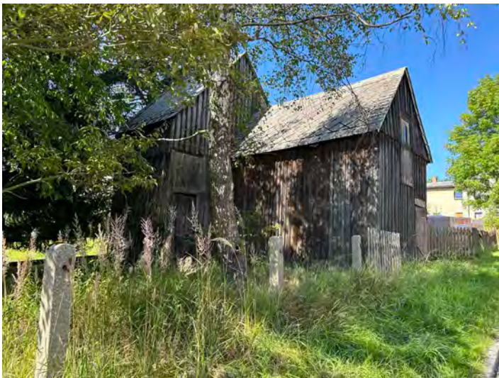
Abb. 13 Flnr.23, Straßenansicht Nebengebäude mit Freifläche, Nordosten
