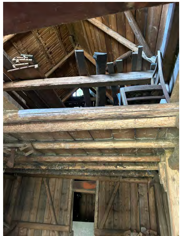
Abb. 18 Flnr. 23, Nebengebäude, Teilansicht Erd- und Dachgeschoss mit Zwischendecke
