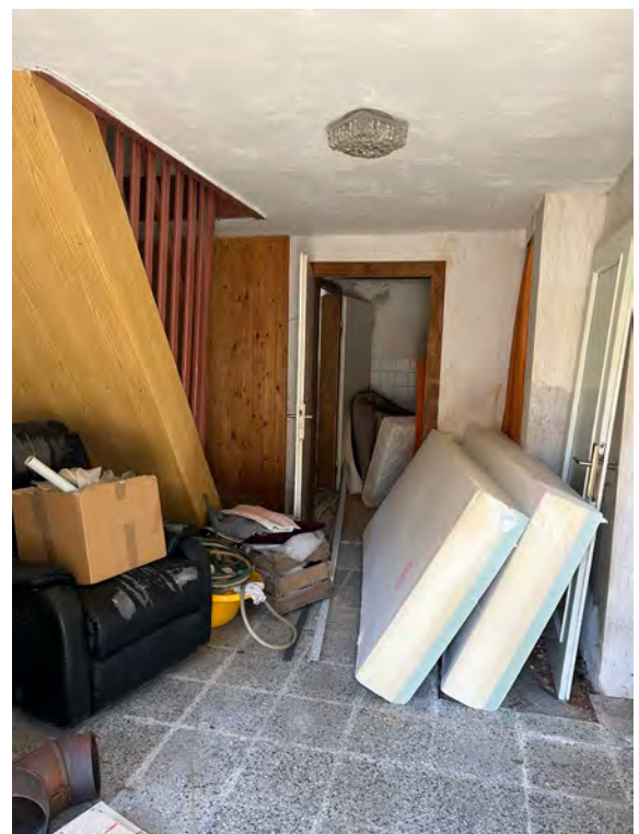
Abb. 05 Wohngebäude, Erdgeschoss, Teilansicht des Hausflures
