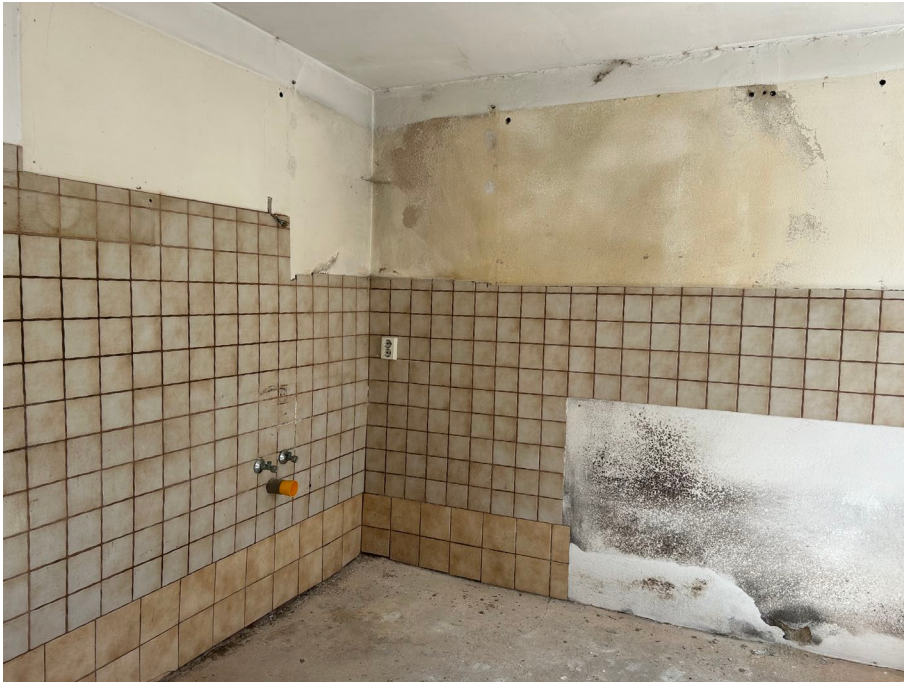
Abb. 09 Wohngebäude, Erdgeschoss, Teilansicht der Küche
