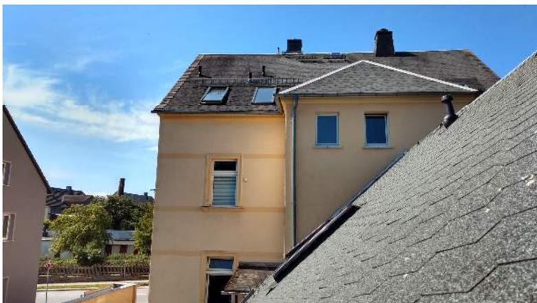
Bild 19: Fenster Altbestand über dem Dach des EFH nicht verschlossen
