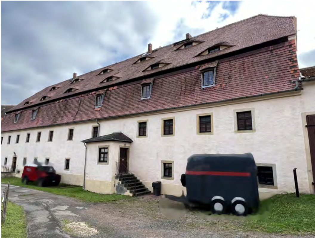
westliche Längsseite des Gebäudes Am Rittergut 5, 6
