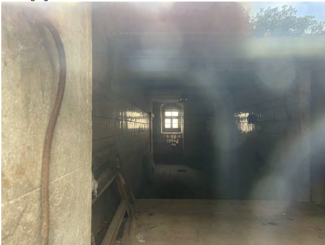
Blick durch ein Fenster an der Gebäudeostseite im EG
