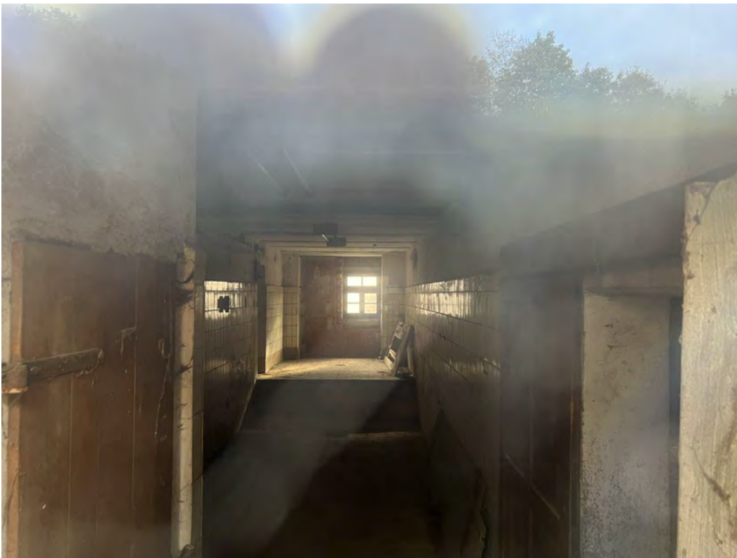
Blick durch ein Fenster an der Gebäudewestseite im EG
