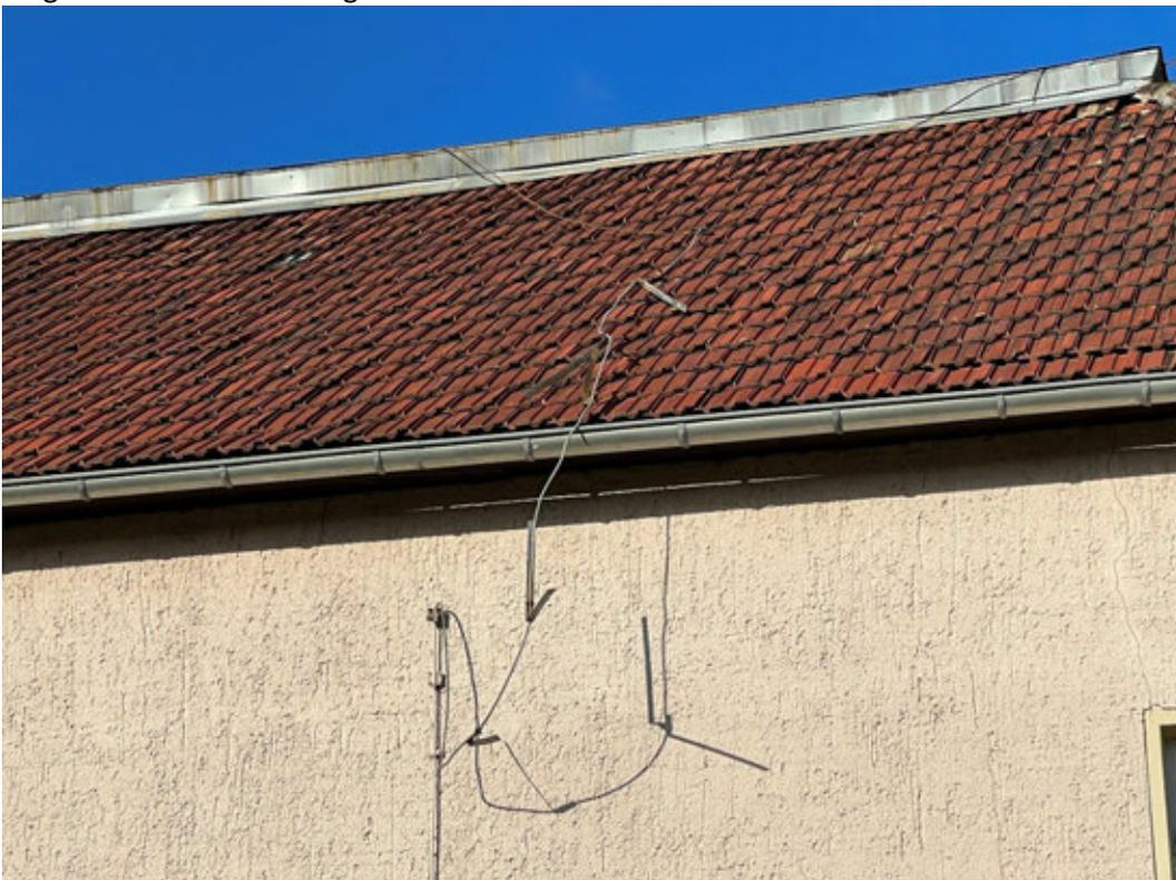
fehlende Befestigung der Blitzschutzanlage
