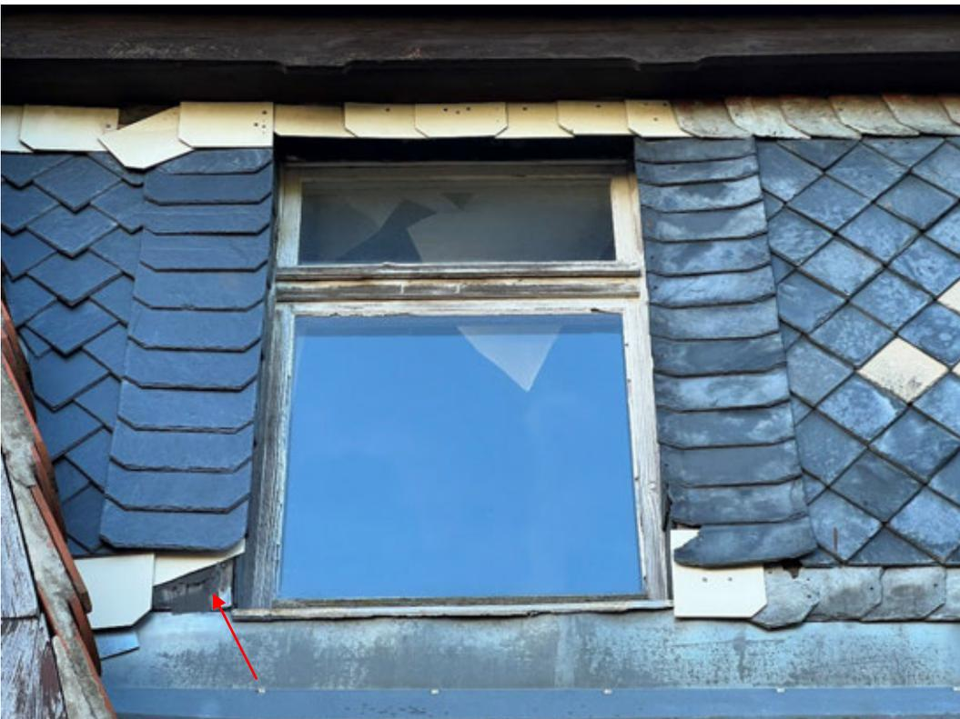
freiliegende Holzbauteile der Fensterleibung (Pfeil) und herunterhängende Tapete in dem Raum
