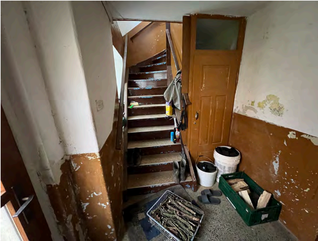
Hausflur im EG von Haus 1 (Am Rittergut 3)
