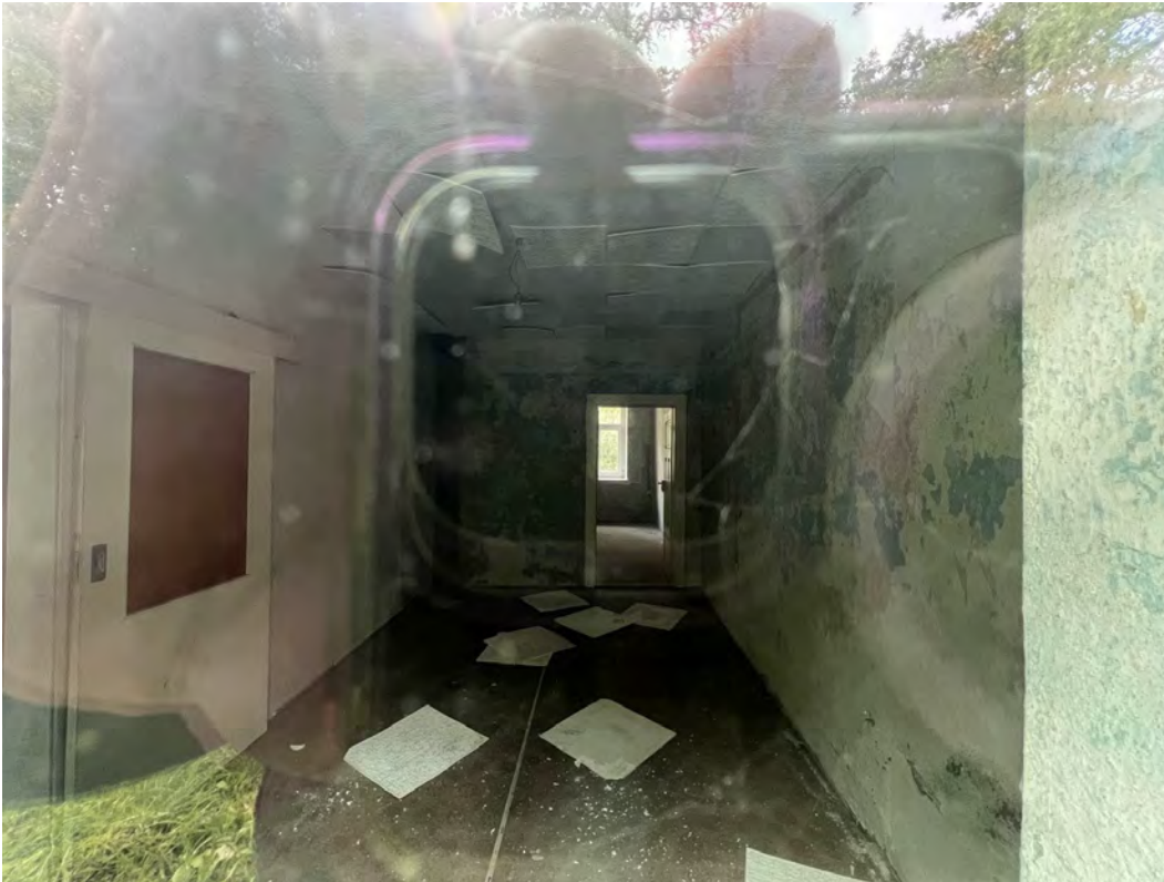
Blick durch ein Fenster im Erdgeschoss an der Dorfstraße
