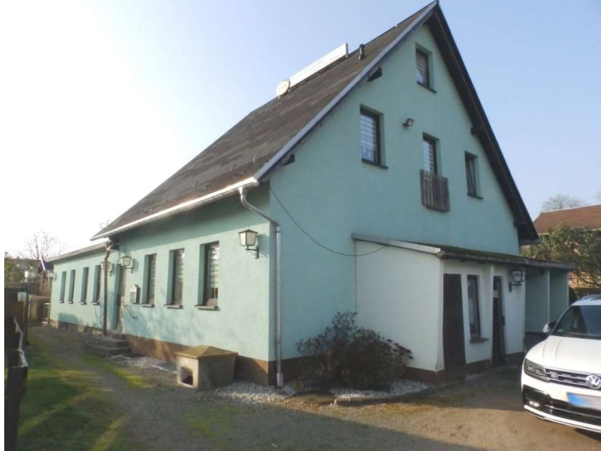
Bild 1: Gaststättengebäude mit Einliegerwohnung, Nordflügel
