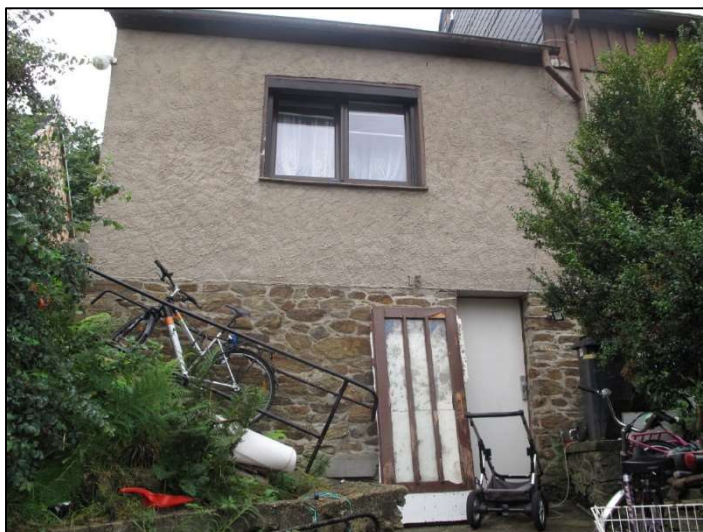
Vorderseite mit Eingang zum Kellergeschoss
