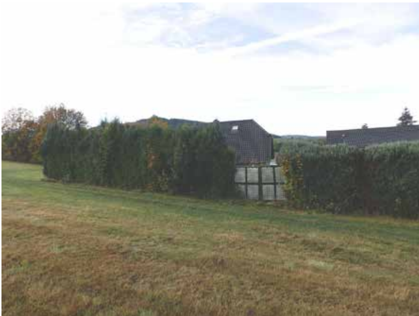
Bild 10: Ansicht des Bewertungsobjekts aus östlicher Richtung
