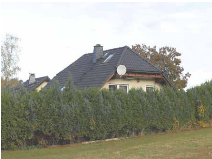
Bild 12: Ansicht des Zweifamilienhauses aus südlicher Richtung
