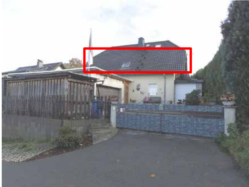
Bild 1: Straßenansicht des Bewertungsgrundstücks, mit Kennzeichnung der Lage der Wohnung 2
