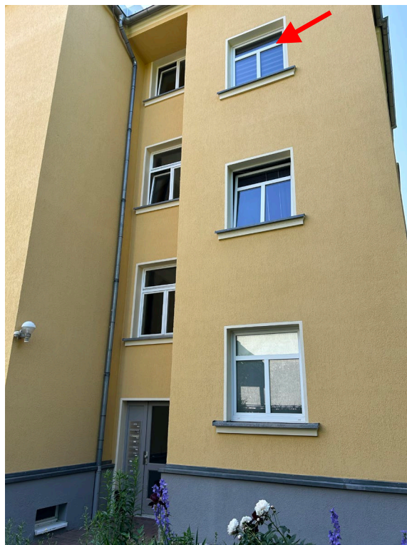
Abb. 03 Teilansicht des Gebäudes von Südosten mit Hauseingangssituation und Lage von WE 7 im 2. Obergeschoss
