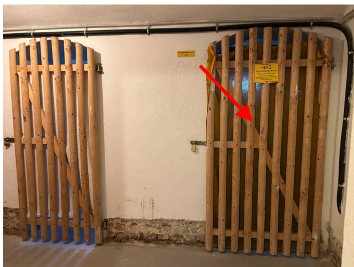
Abb. 13 Kellergeschoss, Ansicht Zugang zu Keller Nr. 7
