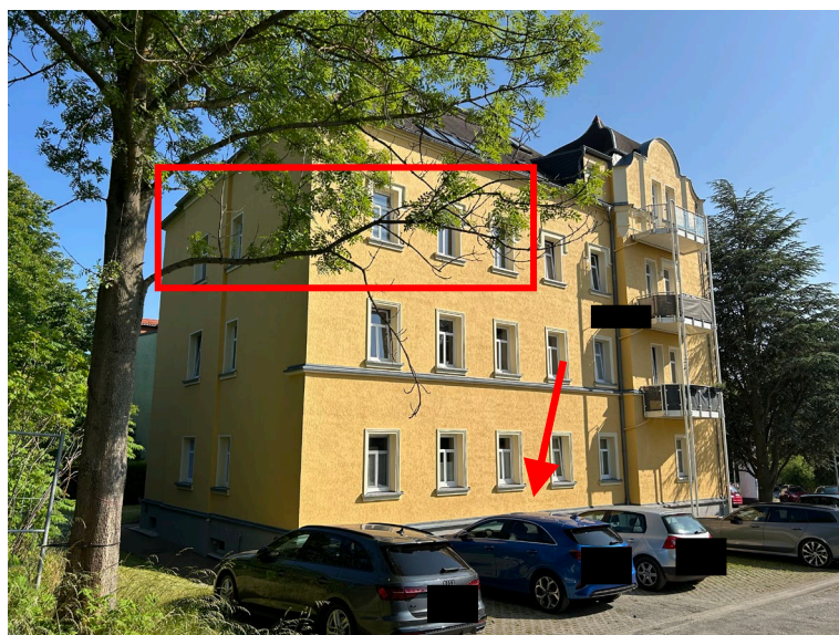
Abb. 02 Ansicht des Gebäudes von Nordwesten mit Lage der Wohnung WE 7 im 2. Obergeschoss und Teilansicht der Stellplatzfläche mit Lage von Stellplatz S 7
