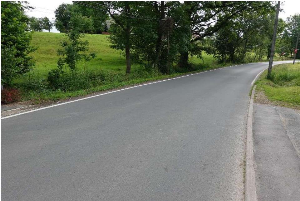
Bild 2: Blick entlang der Fahrbahn
